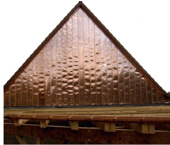
Bild 2.: Zum Vergleich nochmals die Abbildung der Giebelbekleidung aus Heft 5/2005. Unnötig zu erwähnen, dass ein solches Erscheinungsbild nicht dem verwendeten Baumetall, sondern nur dem Verarbeiter anzulasten ist.
