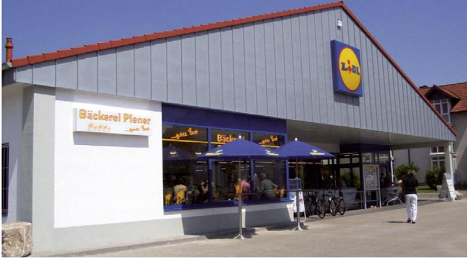
Bild 1.: Eine von der Firma Werner Brieden aus Medebach sauber ausgeführte Giebelbekleidung aus Titanzink.
