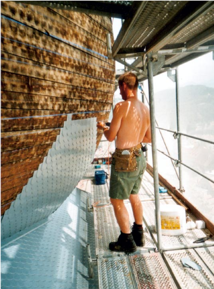
Basis des Zwiebelturms und Beginn der Deckungsarbeiten auf Holzschalung ohne Trennlage. Gut zu erkennen sind die per Laser bestimmten horizontalen Verlegelinien.
