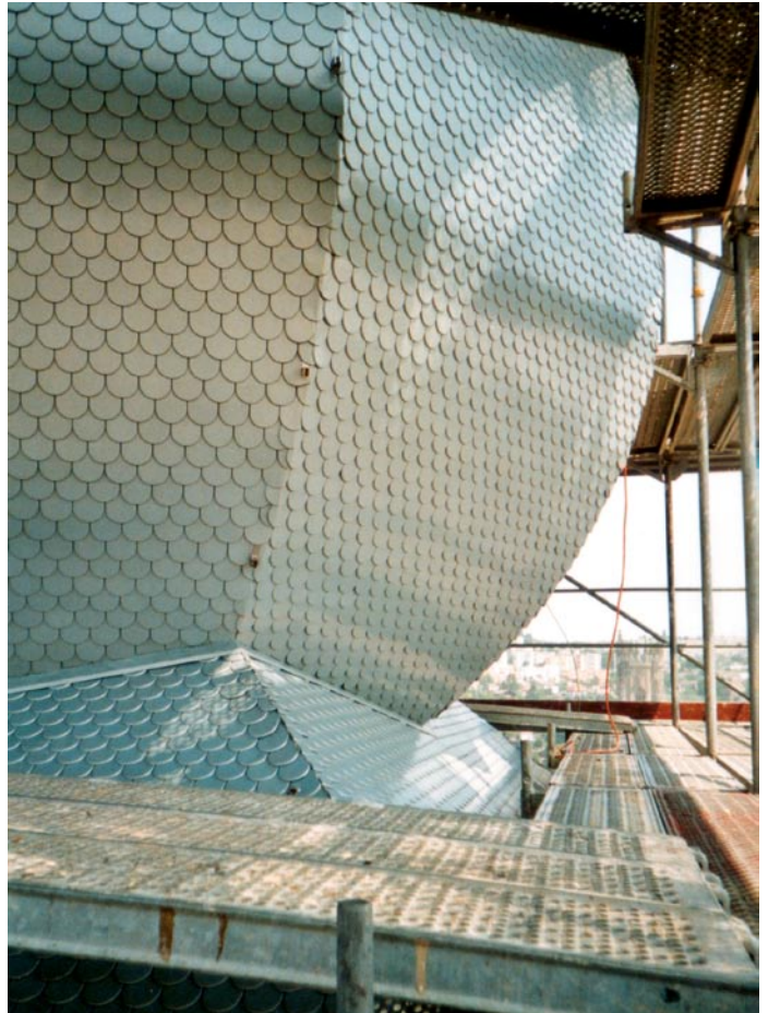
Die Basis und Teile des unteren Zwiebelturms sind fertig eingedeckt. Bemerkenswert sind die saubereren Gratlinien, hergestellt durch entsprechendes Abkanten der Schindeln.
