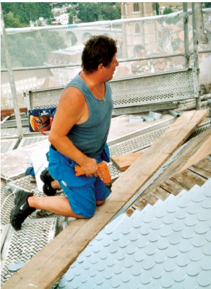
Basis des Zwiebelturms und Beginn der Deckungsarbeiten auf Holzschalung ohne Trennlage. Gut zu erkennen sind die per Laser bestimmten horizontalen Verlegelinien.
