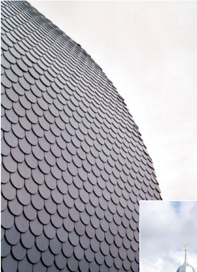
Ein Blick auf den Zwiebelgrat. Seine Bekleidung ist ebenso sorgfältig ausgeführt wie die Deckung der Zwiebellfläche selbst.
