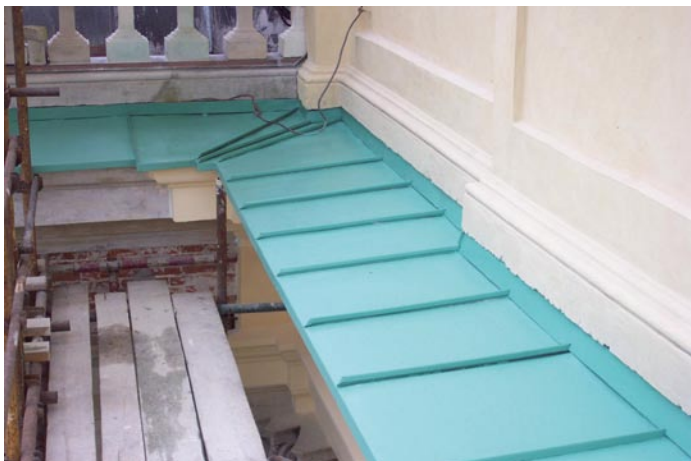
Durch den Einsatz von Metall-Protect entstand auf der Zinkoberfläche der Eindruck einer natürlich patinierten Kupferoberfläche.
