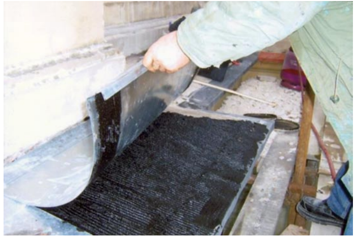
Einfügen eines Teilstücks der Abdeckung. Der Blechkaltkleber ist fachgerecht mit einem Zahnpachtel aufgetragen.
