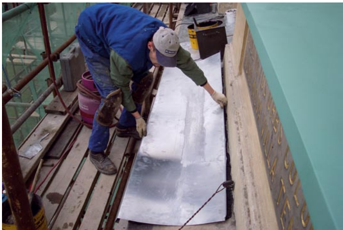
Zahlreiche Metallabdeckungen waren zu erneuern. Mit dem Blech-kaltkleber Enkolit war eine sichere Fixierung auch auf dem empfindlichen Sandstein-Untergrund möglich.
