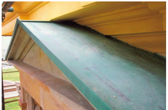
Auch die Abdeckung dieses Tympanon (= Giebfeld über dem Türsturz eines Portals) erhielt durch einen entsprechenden Anstrich seinen optischen Kupferpatina-Effekt.
