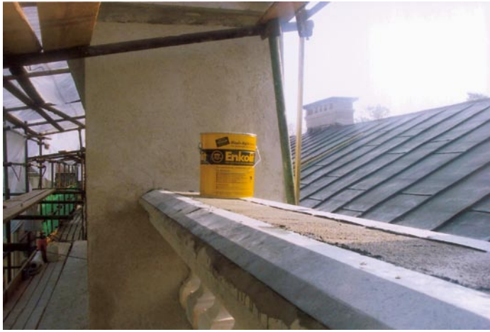
Zahlreiche Metallabdeckungen waren zu erneuern. Mit dem Blech-kaltkleber Enkolit war eine sichere Fixierung auch auf dem empfindlichen Sandstein-Untergrund möglich.
