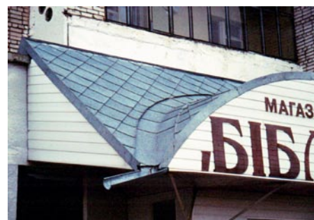
Rautendeckung mit Kehle an einem Vordach.
