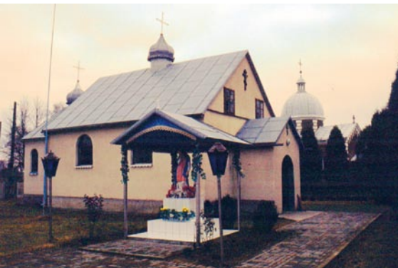
Auch diese Dorfkirche hat ein Dach aus verzinktem Stahl in Tafeldeckung.
