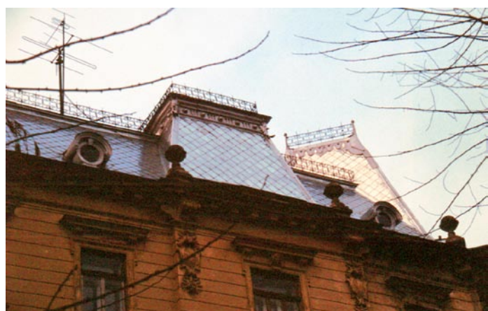
Rautendeckung mit Kehle an einem Vordach.
