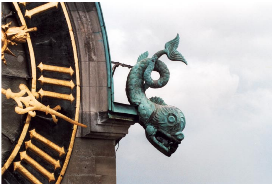
Bild 11.: Einer der insgesamt vier kunstvollen Wasserspeier vor der Demontage.
