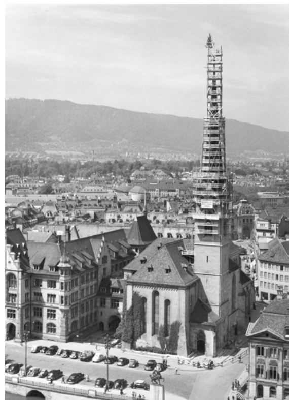
Bild 2: Das Fraumünster mit eingerüstetem Turm während der Instandsetzung im Jahr 1948. Das Gerüst umfasste vom Turmfuß bis zur Spitze 23 Etagen. Die oberste Arbeitsplattform lag 78 m über dem Straßenniveau.
