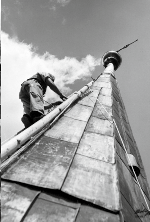
Bild 4: Es gehört schon ein wenig Mut dazu, nur auf einer Leiter die Turmspitze nach Bauschäden zu untersuchen.
