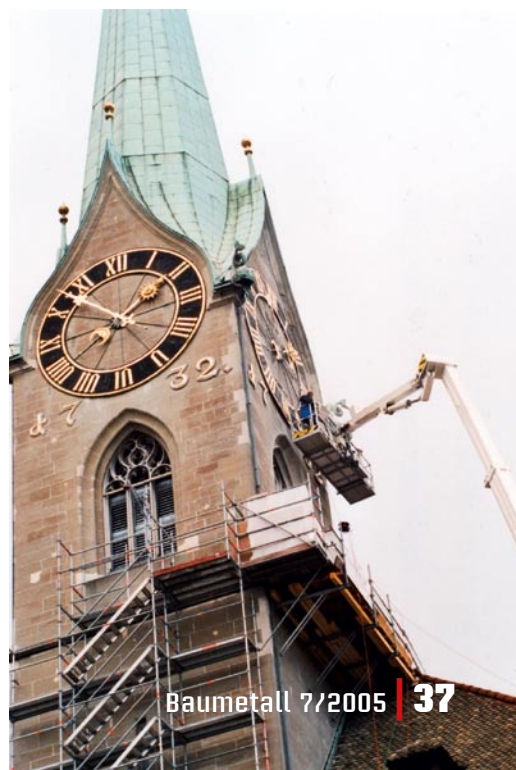
Bild 7: Aufwendige Untersuchung im Jahr 2002. Soweit ein Skylifter reicht, wird der Zustand von Fassaden, Dächern und Ornamenten untersucht und fotografisch dokumentiert.
