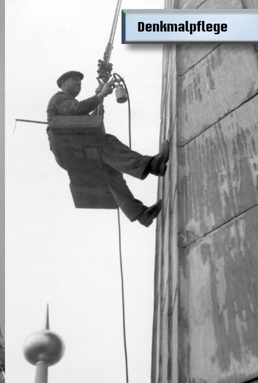
Bild 5: Bis zu 50 Jahre dauert es, bis sich auf Steiflächen eine gleichmäßige Patina gebildet hat. Um diesen Vorgang zu beschleunigen, besprühte 1948 ein Mitarbeiter in luftiger Höhe die frisch verlegten Kupfertafeln mit einer geheim gehaltenen Speziallösung, um sie künstlich altern zu lassen.
