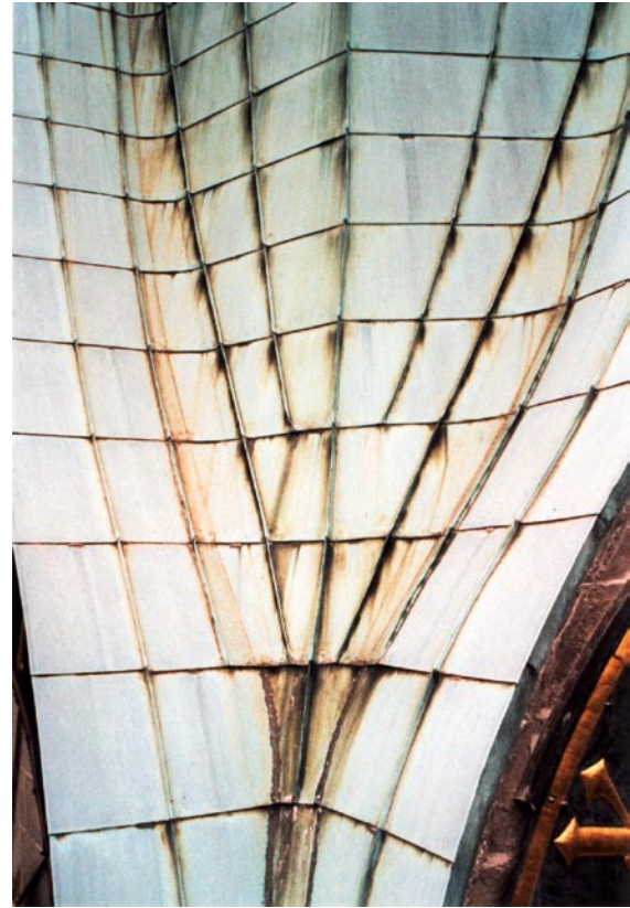
Bild 9.: Doch die Hafte haben sich größtenteils aus der Holzschalung gelöst und die Flächen müssen ersetzt werden.
