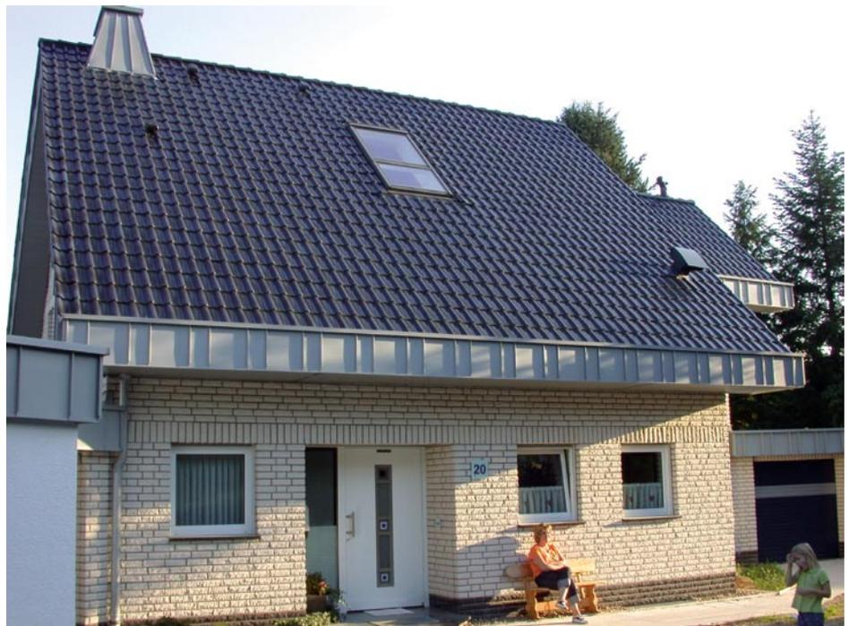
Bild 9.: Mit der Ausklinkeinheit EHA hergestellte Traufbekleidungen an einem Wohnhaus. Ausführung der Klempnerarbeiten: Langel, Köln.
