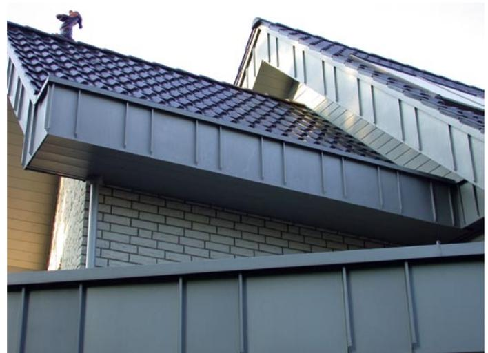
Bild 10.: Trauf- und Ortgangbekleidungen in äußerst sauberer Optik.
