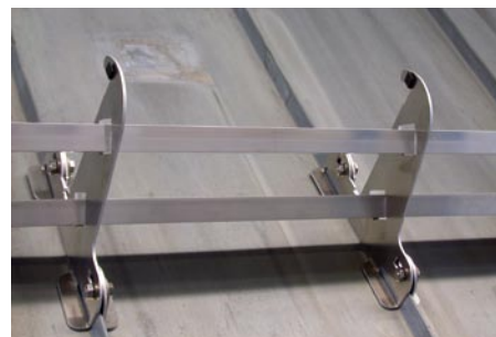
Bild 3.: Ihre quadratischen Öffnungen dienen andererseits der Aufnahme von Vierkantprofilen.
