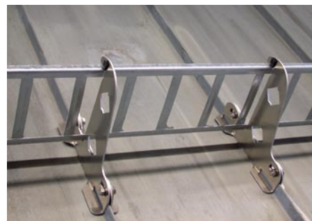
Bild 2.: Die Schneefangstützen haben eine Doppelfunktion. Sie können einerseits im vorderen Bereich 50 mm hohe Schneefanggitter aufnehmen.
