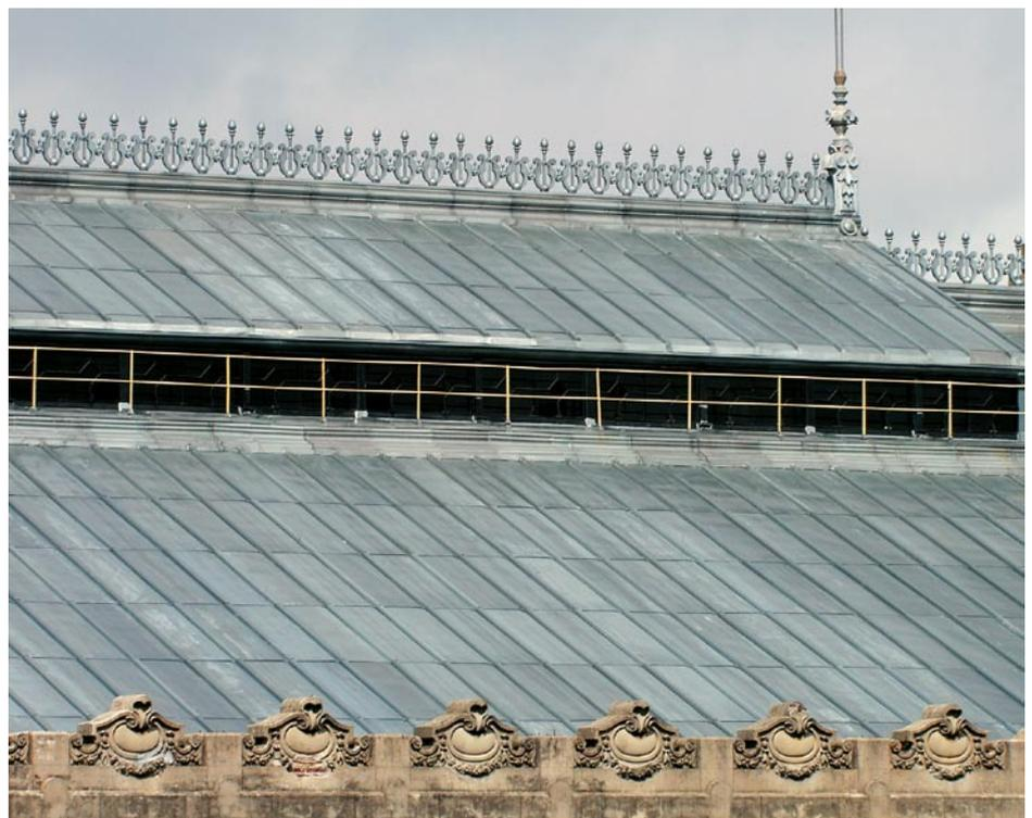
Das Hauptdach ist in Leistentechnik und als Tafeldeckung ausgeführt.
