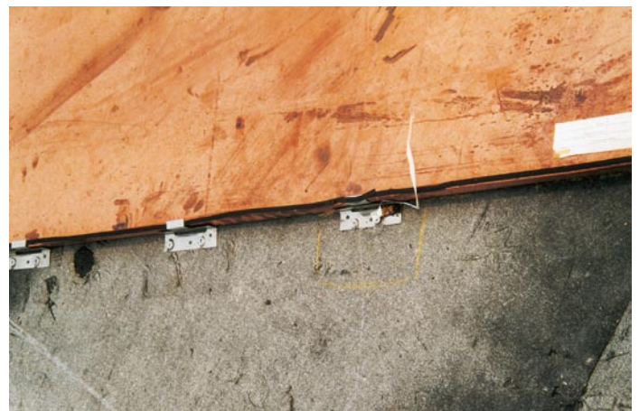
Die Befestigung der Edelstahl-Hafte erfolgt mit jeweils zwei selbstbohrenden und furchenden Schrauben (Foto: KME, Osnabrück).
