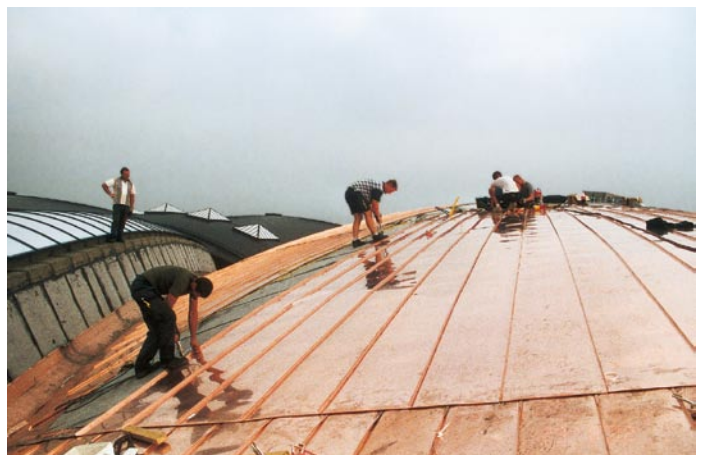
Zurück auf dem Dach. Am Verlauf der Doppelstehfalte ist unschwer zu erkennen, dass an diesen Kuppeln keine Fläche wirklich „rund“ ist. Überhaupt gestaltete sich die Verlegung der Scharen schwierig, da die Radien der zu deckenden Flächen häufig wechseln und sich somit unterschiedliche Scharenbreiten in der Fläche ergeben (Foto: Kentzler, Dortmund).
