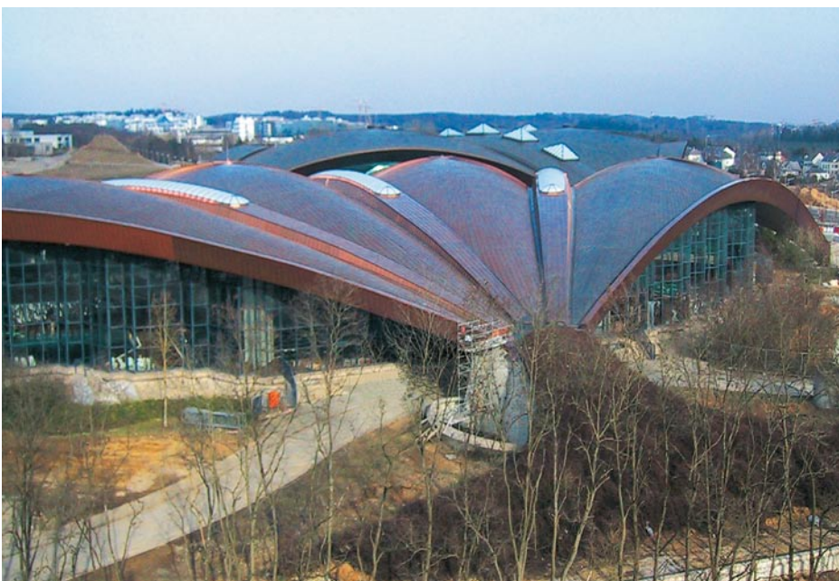
Ein Blick auf das fertige Kupferdach der Olympia-Schwimmhalle (Foto: Deutsche Foamglas GmbH, Haan).
