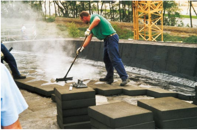
Vor Beginn der Klempnerarbeiten wurden die Foamglas-Dämmplatten in Heißbitumen eingeschlämmt, um eine Dampffusion im Fugenbereich zu unterbinden (Foto: KME, Osnabrück).
