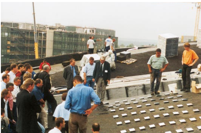
Planer, Handwerker und andere Bauschaffende beobachten an einem Tag der Offenen Tür das Geschehen auf der Dachfläche (Foto: Kentzler, Dortmund)
