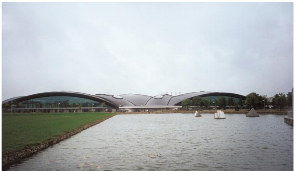
Blick von der Olympia-Schwimmhalle über das Verbindungsgebäude auf das Kupferdach des Kultur- und Sportzentrums mit seiner typischen Schareneinteilung. Auf jeder dieser insge- samt drei Kuppelflächen befinden sich mehr als 1100 konisch und 450 parallel geschnittene Scharen (Foto: KME, Osnabrück).
