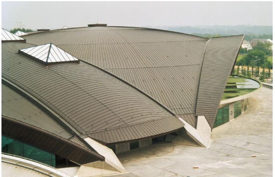
An den Widerlagern der Tragkonstruktion läuft das Regenwasser in den Enden der Kehlrin- nen zusammen. Bei Regen rauschen hier bis zu 90 l/s in einen dahinter liegenden Auffangbe- hälter (Foto: KME, Osnabrück).
