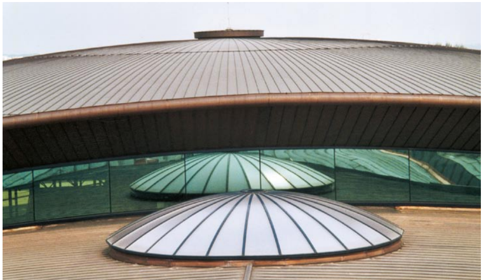
Blick von der Olympia-Schwimmhalle über das Verbindungsgebäude auf das Kupferdach des Kultur- und Sportzentrums mit seiner typischen Schareneinteilung. Auf jeder dieser insge- samt drei Kuppelflächen befinden sich mehr als 1100 konisch und 450 parallel geschnittene Scharen (Foto: KME, Osnabrück).
