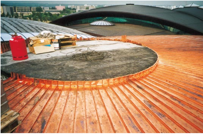
Ausbildung eines konstruktiv erforderlichen Gefällesprungs, denn es geht auf die Null-Grad-Marke zu (Foto: KME, Osnabrück).
