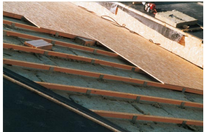
Die Dachunterkonstruktion ist belüftet, die OSB-Platten werden später mit einer Trennlage abgedeckt (Foto: KME, Osnabrück).
