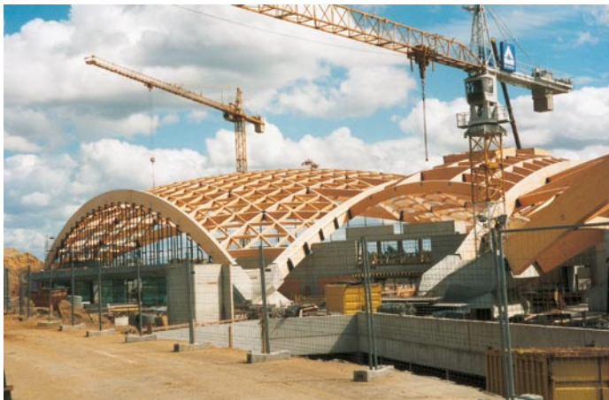
Das Traggerüst für das neue Kultur- und Sportzentrum lässt ahnen, dass auch diese Dachflächen für die Klempner kein Zuckerlecken bedeuteten. Die äußeren Leimbinder sind 50 cm breit, 2 m hoch und haben eine Spannweite von 90 m! (Foto: KME, Osnabrück).
