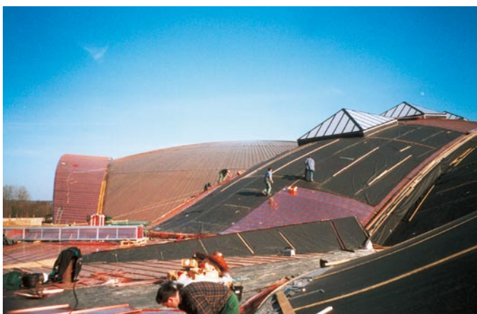
Bis zu 30 Handwerker waren zeitgleich mit der Dachdeckung beschäftigt. Pro Tag wurde im Schnitt eine Tonne Tecu-Classic verarbeitet (Foto: KME, Osnabrück).
