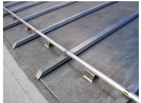
Einrohrschneefang von SM-Systeme aus Ludwigsburg, speziell entwickelt für das Klick-Leistensystem von Rheinzink. Das Schneefangrohr und die in der Scharenmitte angeordneten Eishalter bestehen aus Aluminium.
