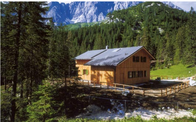
Die Krinner-Kofler-Hütte bei Mittenwald mit traditionellem Satteldach, ausgeführt in Doppelstehfalztechnik mit Rheinzink „vorbewittert“ schiefergrau.
