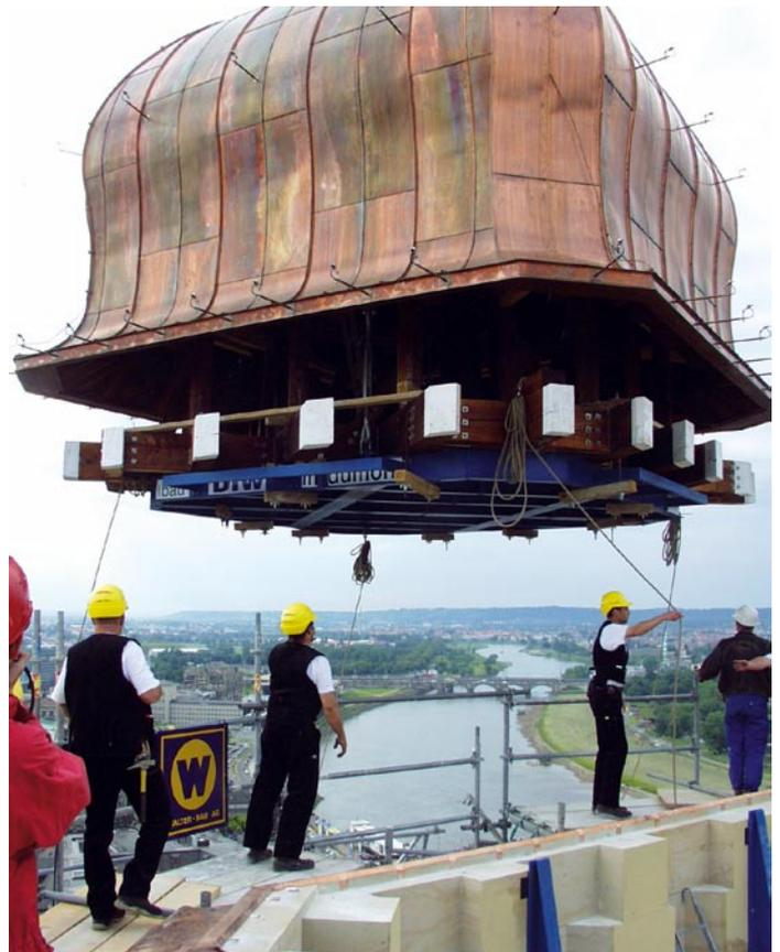
Höchste Anspannung: Keiner der Beteiligten hat jetzt noch Augen für das grandiose Elb-Panorama, denn wenige Minuten später muss die schwere Haubenkonstruktion maßgenau in das Auflager eingepasst werden.
