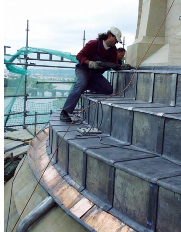
An den Treppenstufen unter der Dachlaterne werden die Fugen verstemmt. Alle Anschlussfugen, die nahtlos an den Sandstein anschließen, sind mit eingesetzten Bleikeilen ausgeführt.
