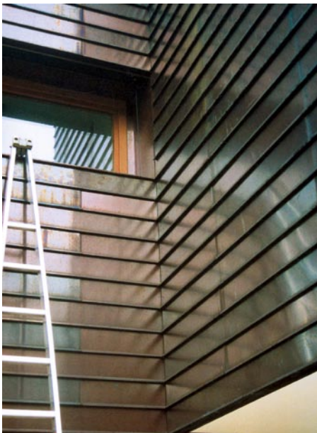
Bild 14.: ... Eckdetails erforderten besondere Sorgfalt.
