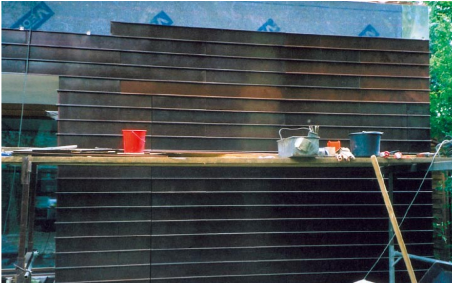
Bild 12.: Die Außenwandbekleidung während der Montagearbeiten.
