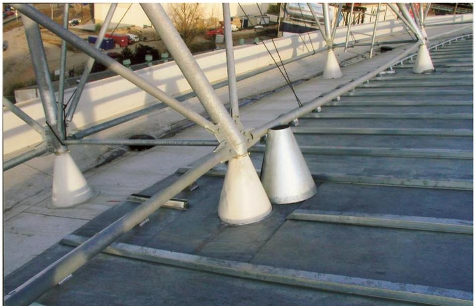
Bild 12: Rohrdurchführungen im Metalldach-Bereich sind handwerklich mit „Stiefel“ und „Glocke“ angeschlossen. Der Anschluss ist somit dehnungstechnisch von der Leistendeckung abgekoppelt.
