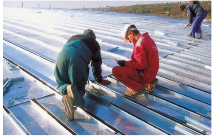
**Bild 8.:** Während der Verlegearbeiten im Bereich des Übergangs vom unteren zum mittleren „Kranz“. Die Größe der Dachkuppel erfordert eine Aufteilung in zwei kreisringförmige Deckbereiche, die durch Querfalze miteinander verbunden wurden.
