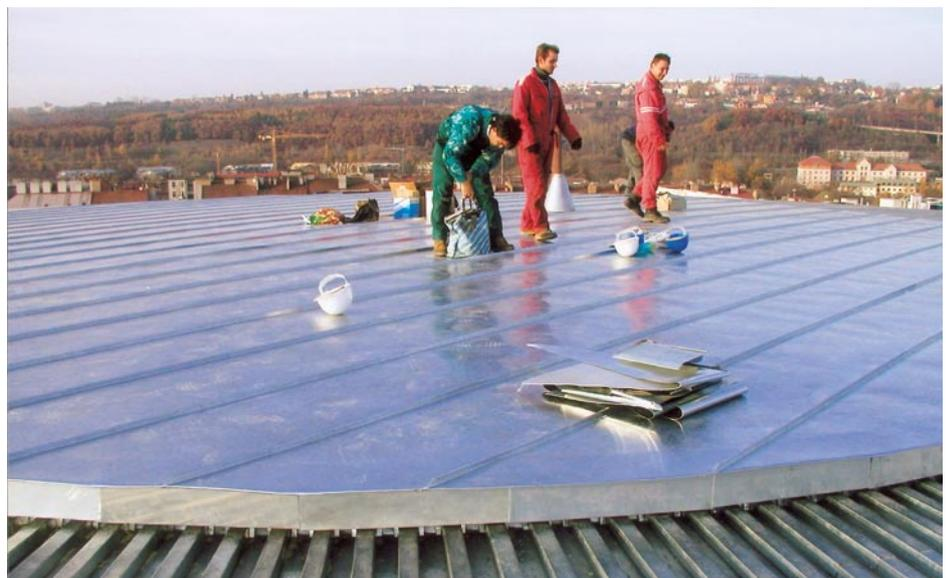
**Bild 10.:** Oberer Kuppelbereich mit seiner um ca. 30 cm höher liegenden „Laterne“, ausgeführt in Doppelstehfalzdeckung. Die Dachneigung beträgt ca. 3°. Im Bildvordergrund ist der Hochpunkt der Klick-Leistendeckung mit Anschluss an die „Laterne“ zu erkennen. Die Scharbreite beträgt hier nur noch ca. 100 mm!
