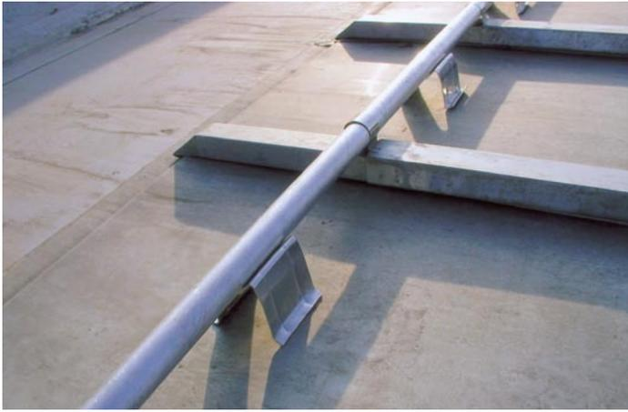
**Bild 7.:** Traufdetail mit fertig gestellter, systemkonformer Schneefang-Vorrichtung in Rohrform und zusätzlichem Eisstop von SM-Systeme aus Ludwigsburg.
