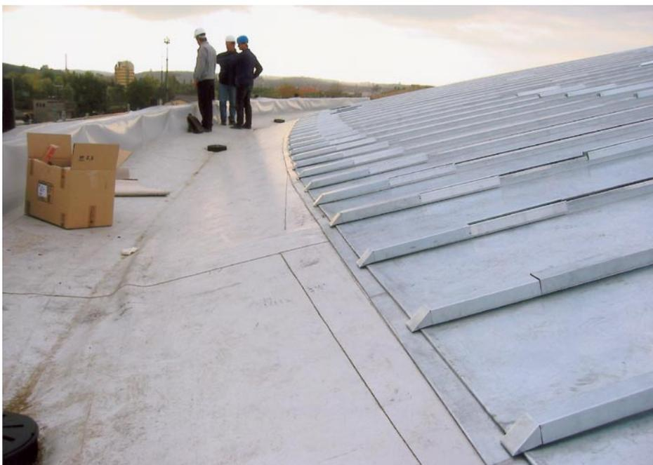
Bild 6.: Traufbereich mit geschweißter Kunststoffolie. Die vorgefertigten Endstücke der Leistenkappen sorgen für einen sauberen Abschluss der Klick-Leistendeckung.
