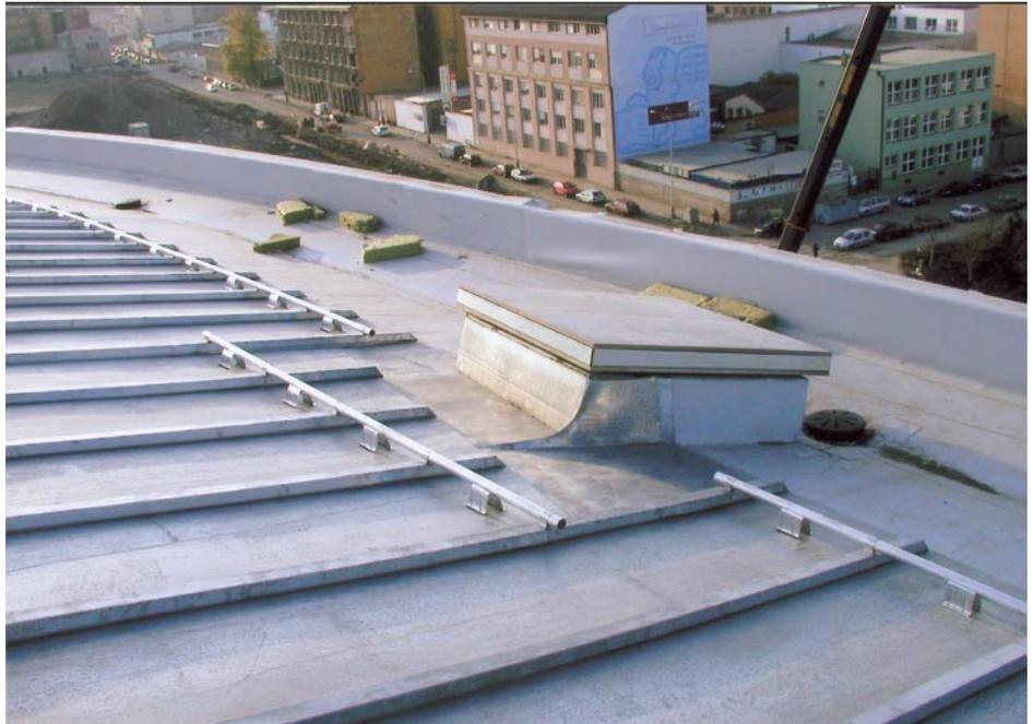
Bild 11.: Durchdringungen im Bereich der Metalldeckung, wie dieser Dachausstieg, sind in traditioneller Falztechnik ausgeführt; der traufseitige Teil ist in die Abdichtung mit Kunststoffolie einbezogen.
