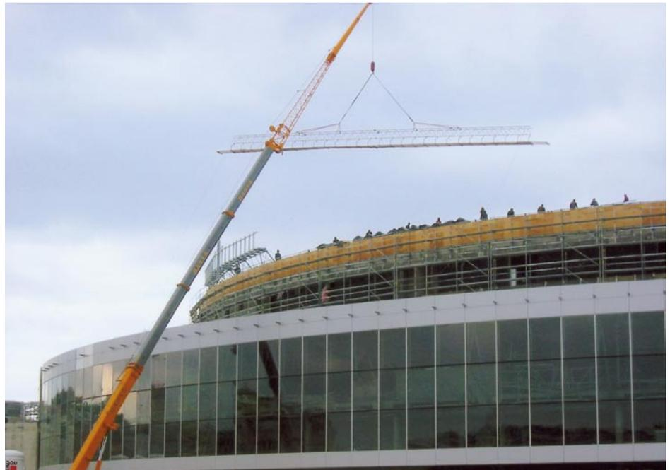
Bild 3.: Vorgefertigte Scharen mit Längen bis zu 32 m gelangen per Mobilkran aufs Dach.
