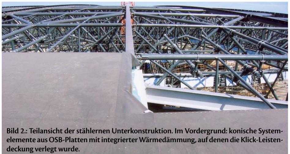
**Bild 2.:** Teilansicht der stählernen Unterkonstruktion. Im Vordergrund: konische Systemelemente aus OSB-Platten mit integrierter Wärmedämmung, auf denen die Klick-Leistendeckung verlegt wurde.
