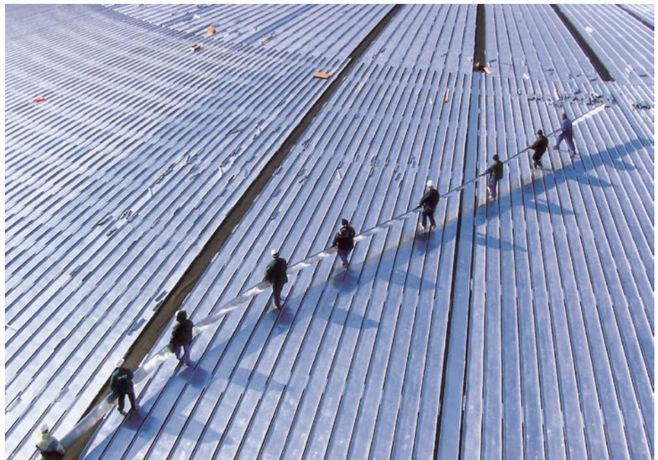
Bild 4.: Beeindruckende Dimensionen: Neun Mann bringen eine der langen Scharen mit ihrem konischen Zuschnitt in Position. Es handelt sich dabei um eine Pass-Schar, mit der sie die aus Toleranzgründen belassenen Aussparungen zwischen den schon verlegten Scharfeldern schließen.
