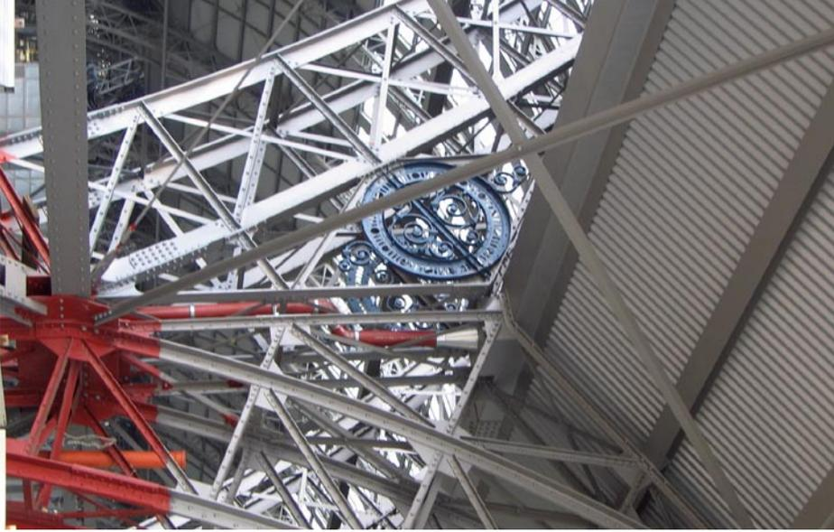
Dämmung montierten. Darauf folgten die ebenfalls gerundeten Aluminium-Profilbahnen vom Typ Rib-Roof 465, die, je nach Verwendungsstelle, 0,7 oder 0,8 mm stark sind.
