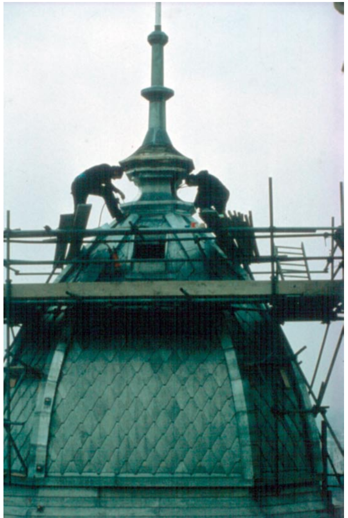
Präzisionsarbeit bei Wind und Wetter: Mancher salzhaltige Sturmwind von der See erschwerte die Arbeit der niederländischen Loodgieter.
