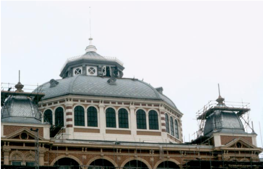
Noch stehen die Gerüste: Mit dem Abschluss der Neu-Eindeckung im Herbst 1978 ist das Meiste geschafft.
