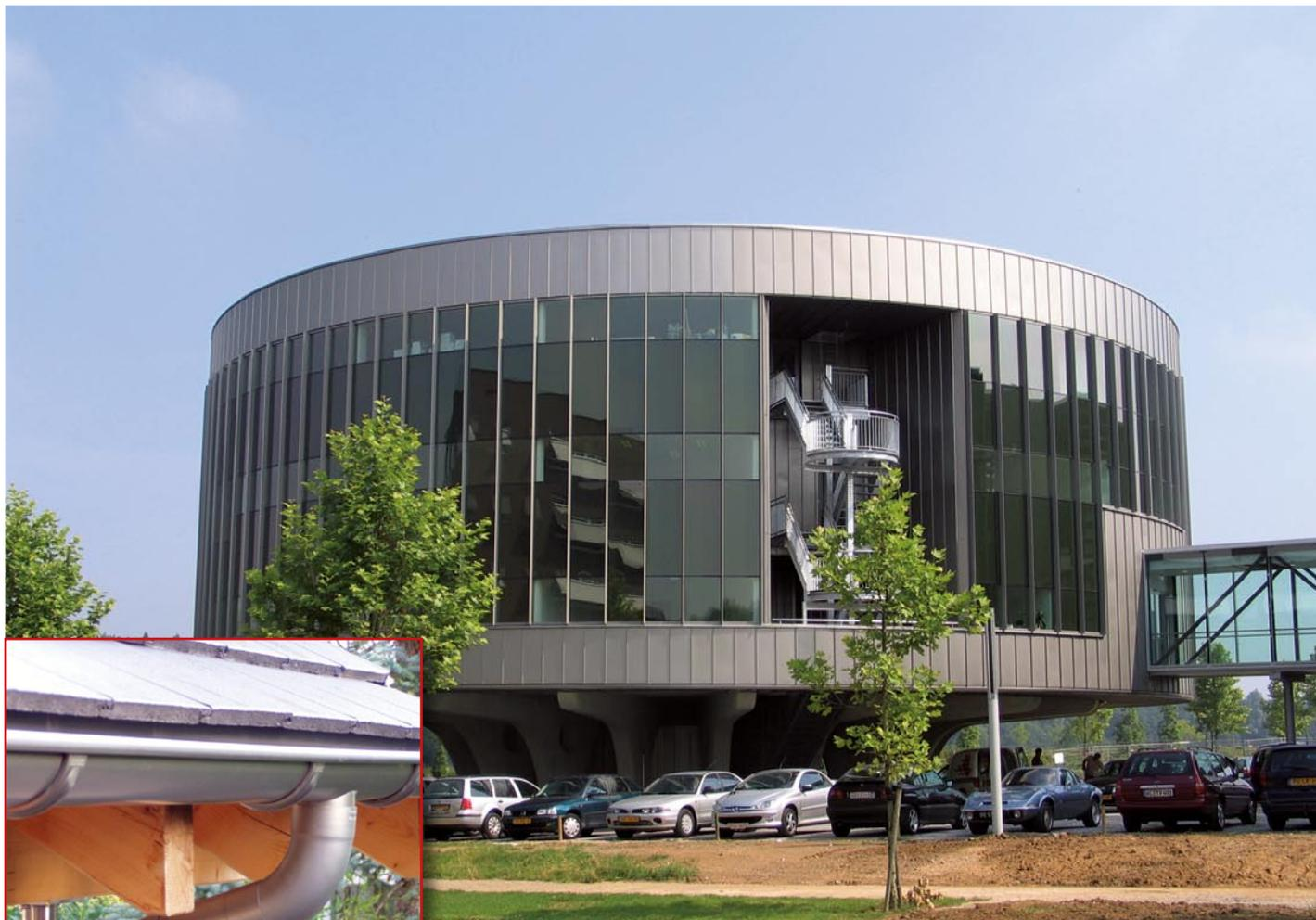
Nedzink Nova ist werkseitig vorpatiniertes Titanzink nach DIN EN 988, also eine Legierung auf Basis von hoch reinem Elektrolyt-Feinzink mit geringen Mengen an zulegiertem Kupfer, Titan und Aluminium. Die gleichmäßige, seidenglänzende titan-graue Oberfläche von Nedzink Nova entsteht im Anschluss an den Walzprozess durch eine chemische Oberflächenbehandlung.
