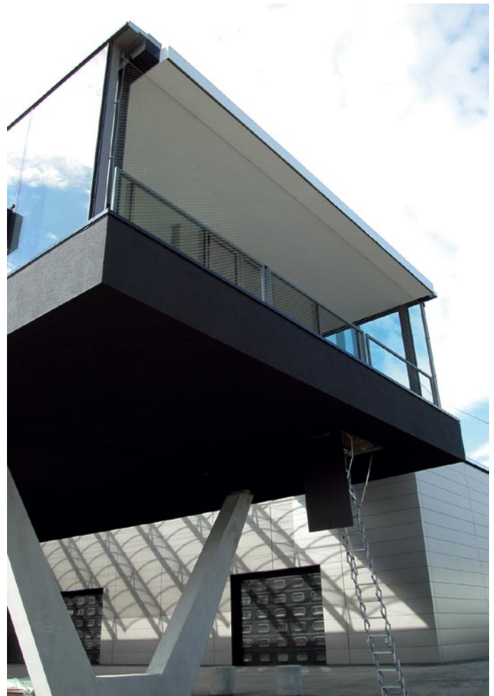
Unter einem Dach vereint: Das Hallendach mit präziser Edelstahlkante überspannt alle Bereiche des Gebäudekomplexes.
