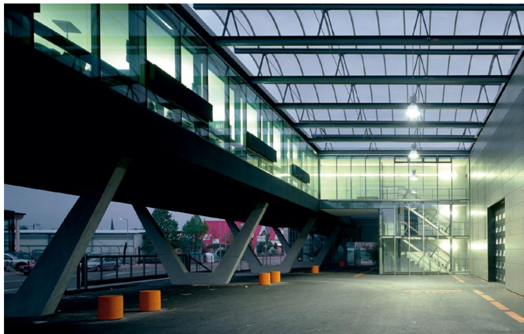
Der Ladehof bei Nacht: Sehr gut zu erkennen sind die sehr sachliche Gliederung durch die mit Domico-Elementen bekleidete östliche Hallenwand, die Elemente des Acryldachs und die Verglasung am Mitarbeiter-Treppenhaus.
