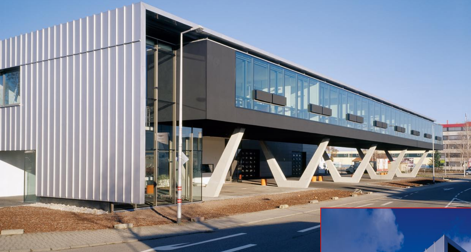
Die Südost-Ansicht von der Hauptstraße aus: Deutlich ist zu erkennen, wie die in Stehfalz-Leistendeckung ausgeführte Südfassade nach vorn ausgreift und den Büro-Riegel einbindet.
