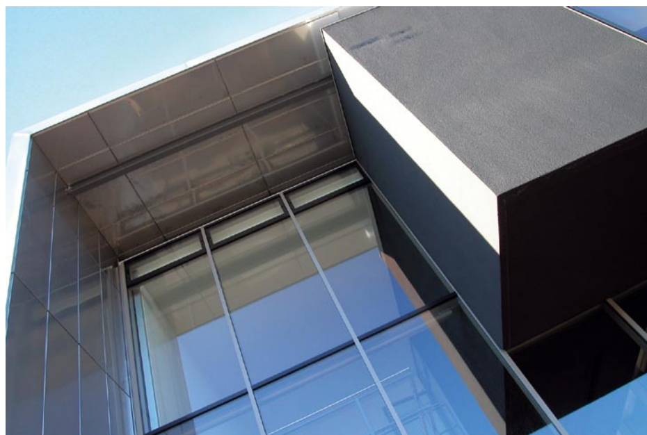
Details am deutlich zurück versetzten Besucher-Treppenhaus in der Südost-Ecke: Seitenwand und Unterseite des Dachüberstandes sind mit Edelstahl-Feinblech verkleidet.
