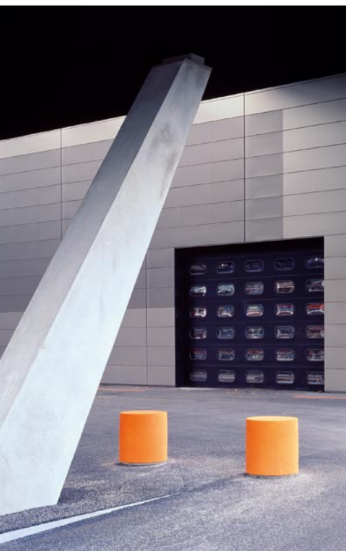
Die Ostfassade im Lkw-Ladehof: Die Domico-Elemente sind teilweise gelocht, dahinter liegen Schallschluckmatten, die den Lärm des Ladeverkehrs mindern sollen.
