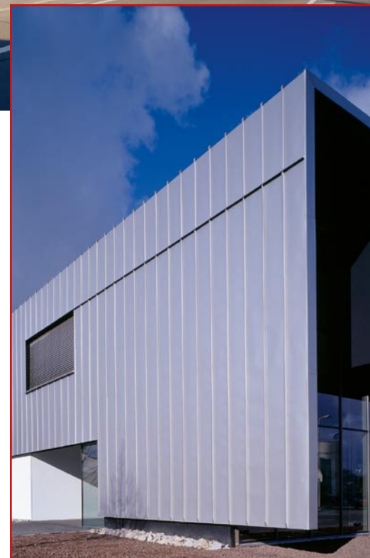
Die Südost-Ansicht von der Hauptstraße aus: Deutlich ist zu erkennen, wie die in Stehfalz-Leistendeckung ausgeführte Südfassade nach vorn ausgreift und den Büro-Riegel einbindet.
