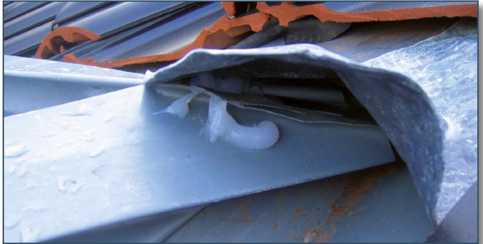
Besonders kreativ: Sooooo kann man natürlich auch den Abschluss einer Gratkappe im Kehlsattelbereich ausführen...
