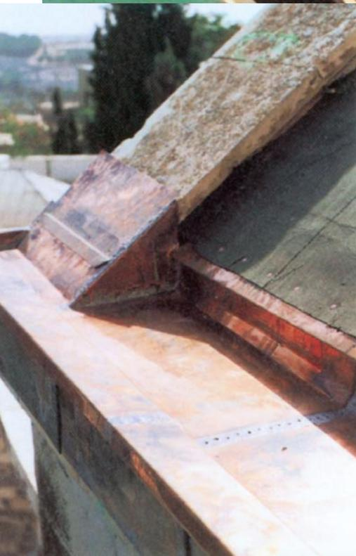
Im ersten Bauabschnitt wurden zunächst die kleinflächigen Seitendächer des Chor-Anbaus mit Blei gedeckt.
