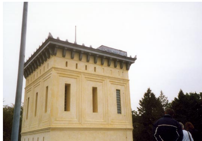
Giebelzier nach antikem Vorbild: Das Dach des zentralen Turmes ist von klassischen Akroterien besetzt, die nach der Neudeckung wieder fachgerecht angebracht wurden.
