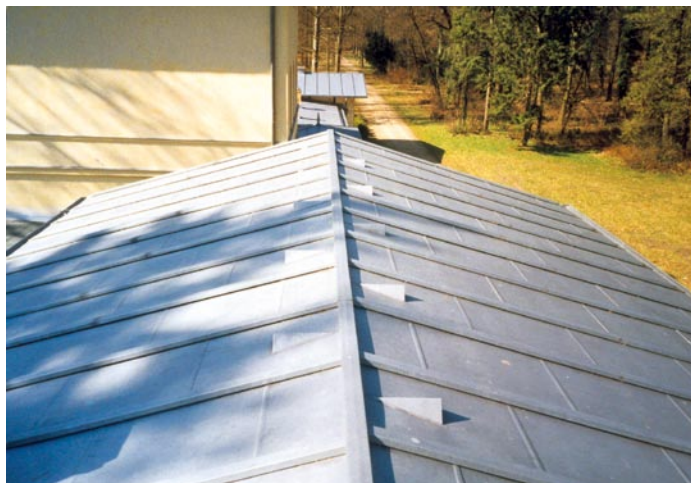
Nicht normgerecht, doch lebenswichtig: Ursprünglich nicht vorhandene Lüftungshutzen wurden in dieser unauffälligen Form vom Denkmalpfleger genehmigt.
