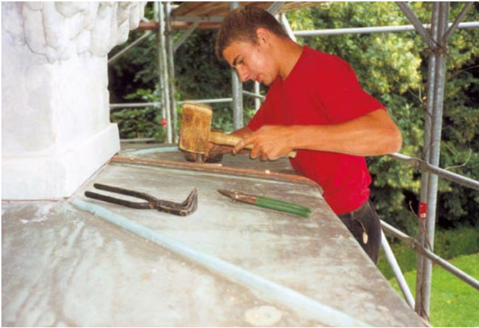
Fingerübung an der Neptungrotte: Die Gesims- und Mauerabdeckungen sollten im Vorfeld der Ultraschallmessung so schonend abgenommen werden, dass sie anschließend problemlos wieder eingebaut werden können.
