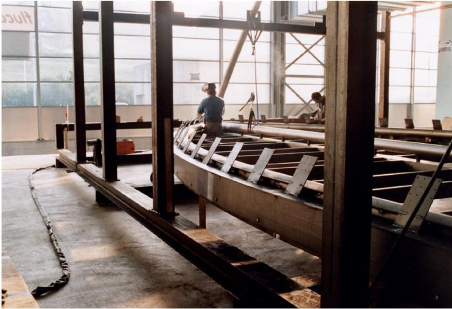
In einer eigens gemieteten Industriehalle in St. Gallen wurde ein riesiger Metallrahmen als Schablone aufgebaut, um die Einzelteile der Konstruktion millimetergenau zu fixieren.
