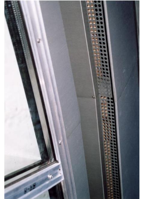
Die am Fenster umlaufend montierten Lüftungsteile gewährleisten auch bei großen Schneehöhen die Hinterlüftung der Zinkdeckung.
