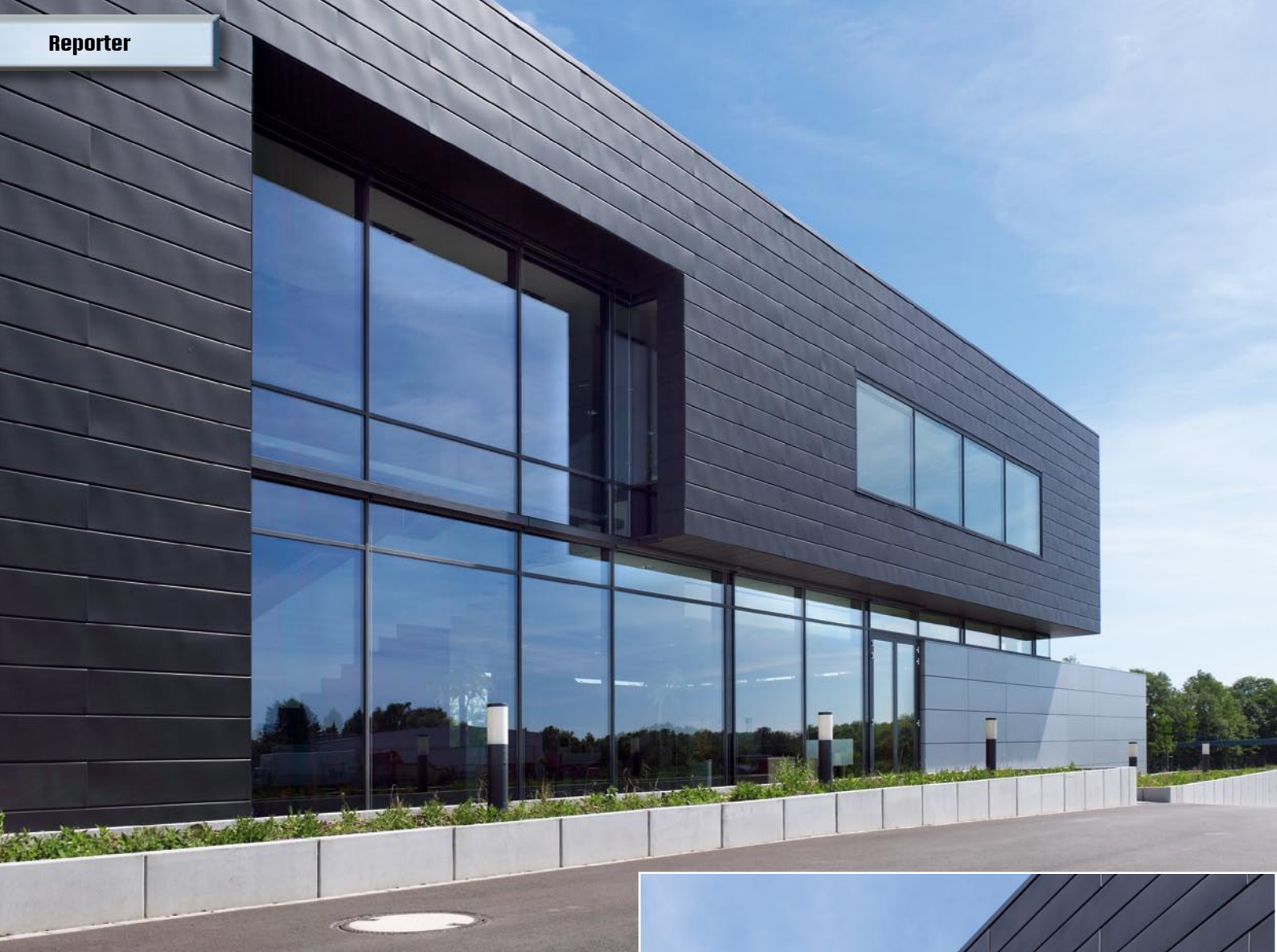
Bild 2.: Das Flatlock-System von VM Zinc ermöglicht eine problemlose Aufnahme der Gebäude und -fassadenachsen ...
