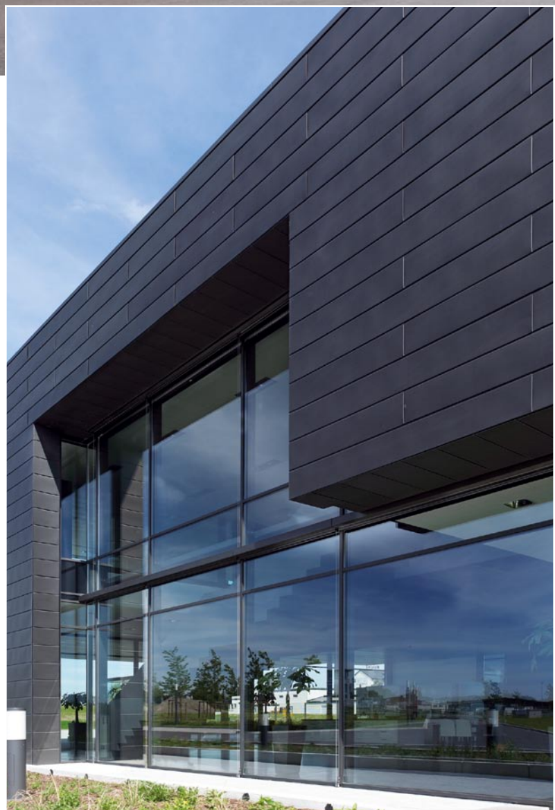
Bild 2.: Das Flatlock-System von VM Zinc ermöglicht eine problemlose Aufnahme der Gebäude und -fassadenachsen ...
