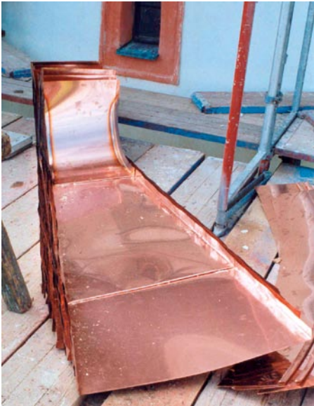
In der Werkstatt Lummel wurden Schare mit Blindfalz für die rund umlaufenden Turmtraufen vorgefertigt.
