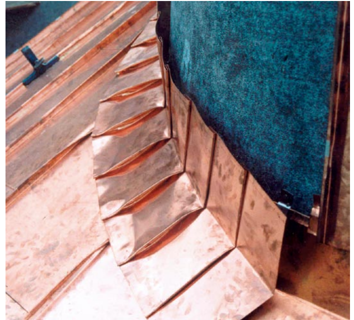
Die Blindfalze sind noch nicht zusammengedrückt – so kann die Kehle leicht an die jeweilige Form angepasst werden.
