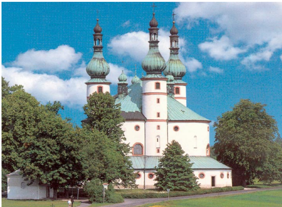
Die Wallfahrtskirche vor der Sanierung: Wind und Wetter hatten der Kappel im Laufe der Jahre ordentlich zugesetzt.
