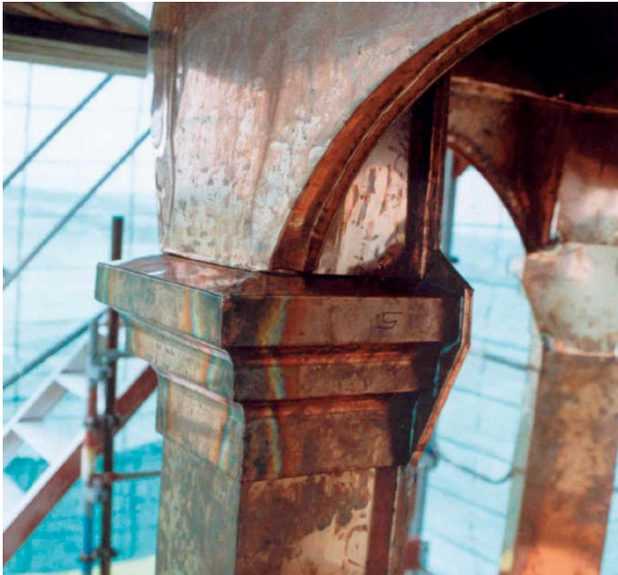
Die Kupferbekleidung der Kapitelle musste auf Gehrung geschnitten und wasserdicht (WIG-)geschweißt werden.
