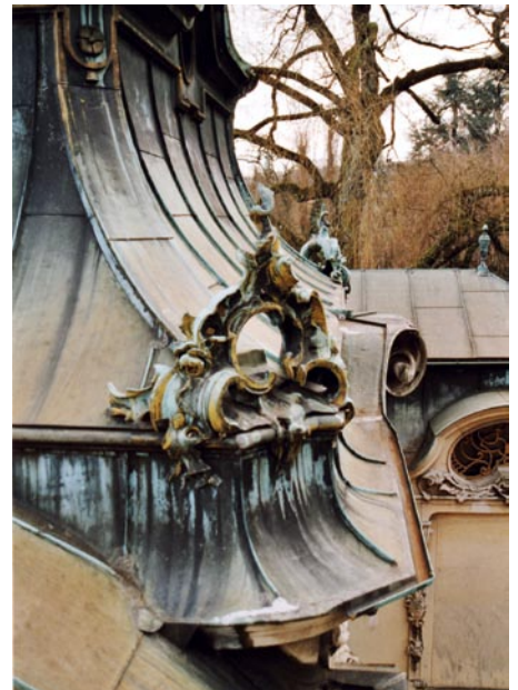
Gealterte Pracht: Die ursprünglichen Ornamente waren 1899 von der Zürcher Spenglerei und Blech-Ornamente-Fabrik W. Schulthess gefertigt und teilvergoldet worden.
