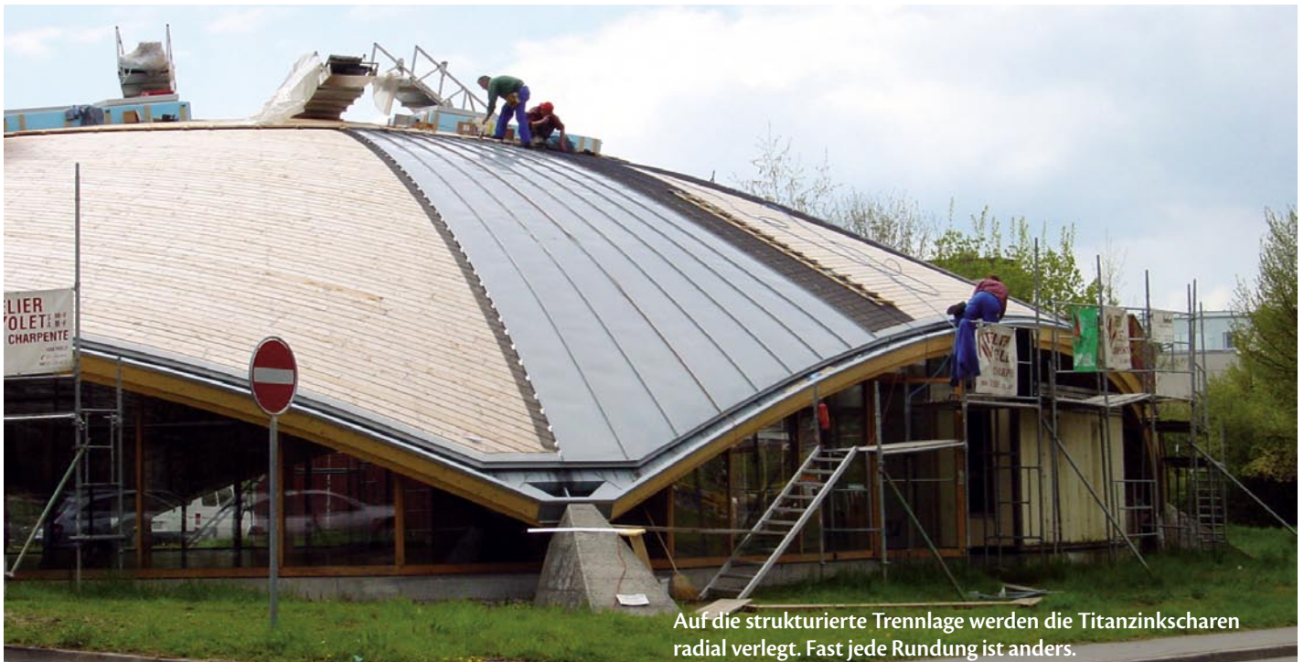
Die Dachrinnen sind bereits eingebaut. Nun wird die Schalung aufgebracht.
