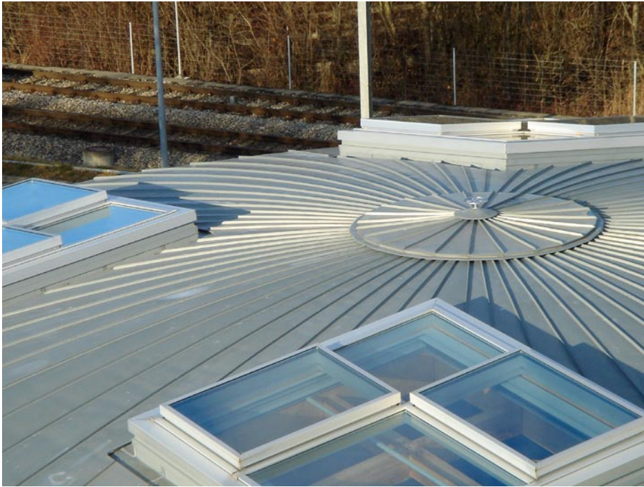
Symmetrisch um die Dachmitte sind die Oberlichter angeordnet. In die kleine, kreisförmig angeordnete Abtrepung ist die Belüftung integriert.
