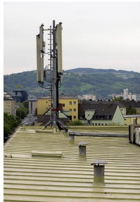
**Statt Neudeckung:** Die gesamte Dachfläche mit Aufbauten, Durchdringungen und Aufkantungungen wurde in diesem Fall mit Kemperol 2K-PUR abgedichtet.
