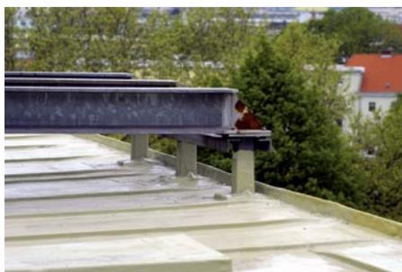
**Hauptsache dicht:** Auch nach der Abdichtung sind die Falze des alten Metalldaches gut zu erkennen. Die Flüssigabdichtung passt sich dem Untergrund an und haftet gut auf allen Materialien.
