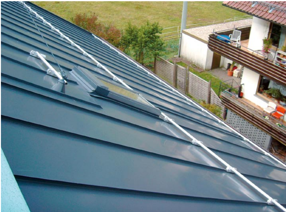
Zweireihiger Schneefang ist bei den Schneemengen im Schwarzwald empfehlenswert.
