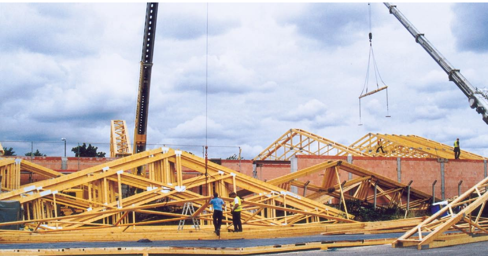
Ein Dach entsteht: Zunächst werden die angelieferten Leimbinder mit Hilfe des Krans vormontiert und bereitgestellt.
