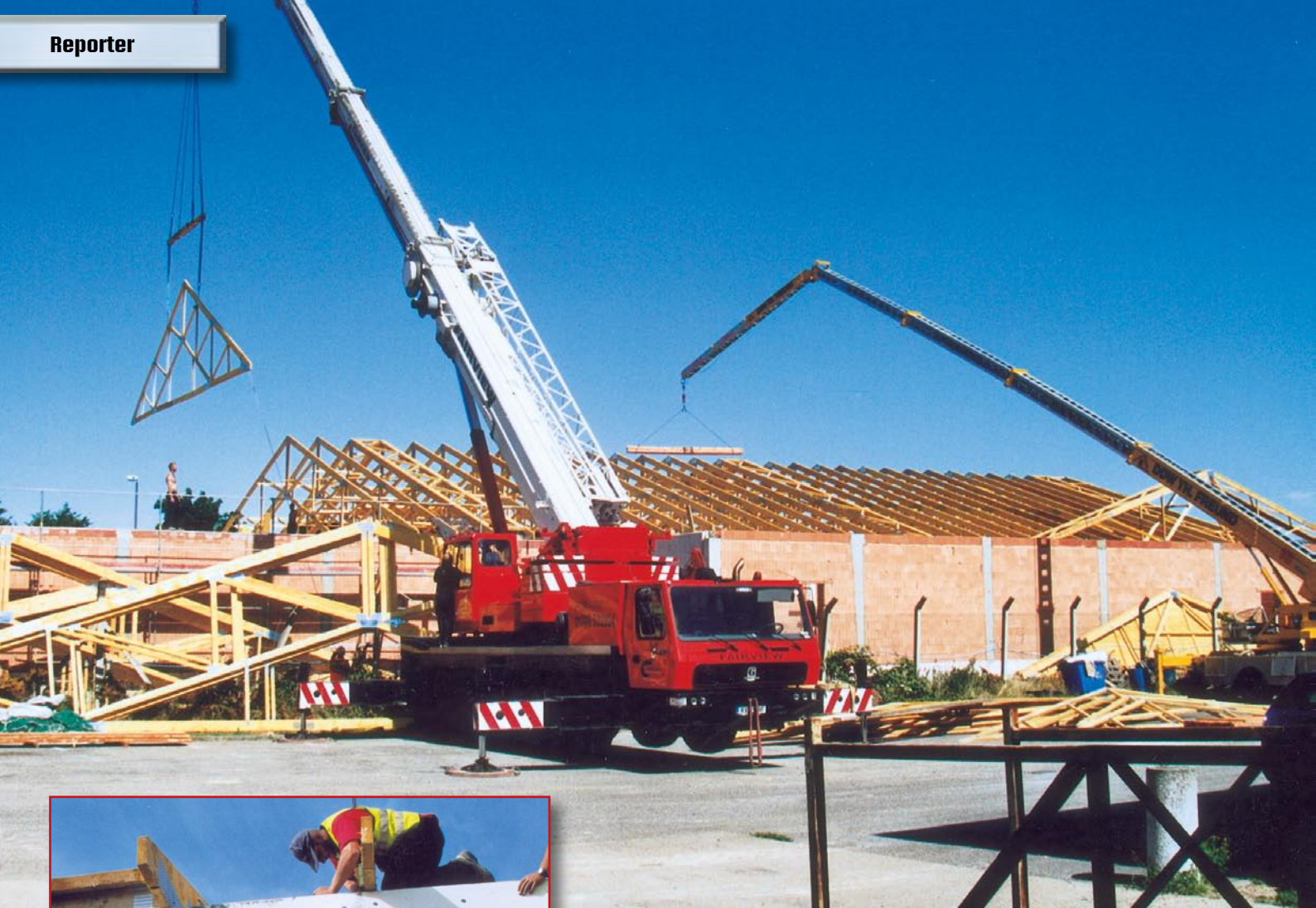
Internationales Kran-Team: Unser Autokran wird von einem „einheimischen“ Kollegen unterstützt, damit die Giebelelemente schneller an ihren Platz kommen.
