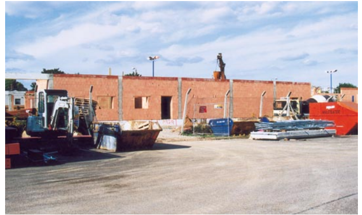
Hier entsteht ein Lidl-Markt: Vom Ringanker aufwärts ist unsere Firma komplett zuständig.
