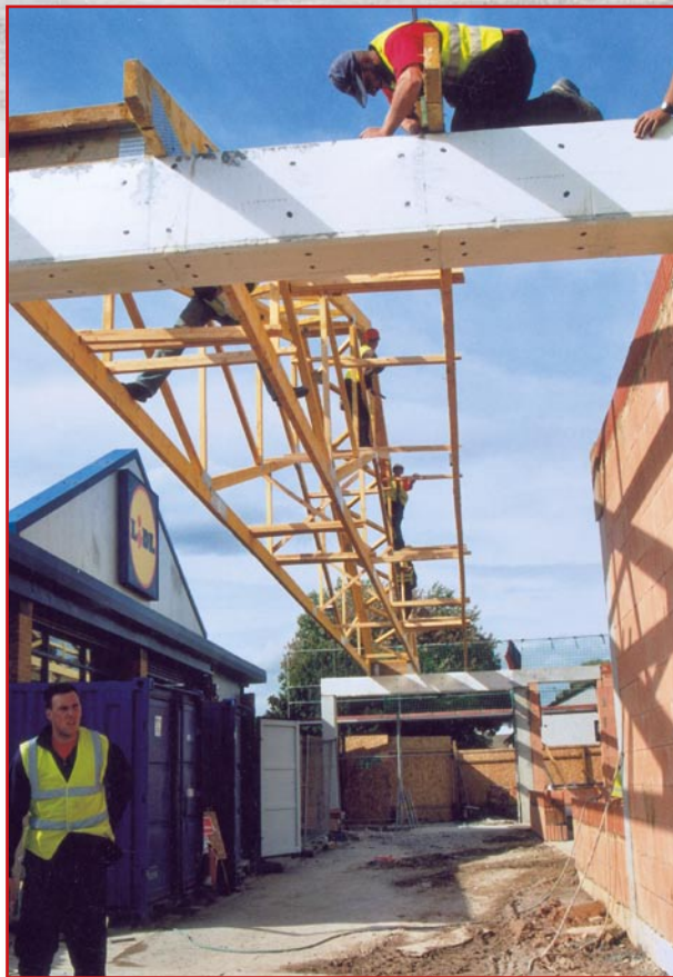
Internationales Kran-Team: Unser Autokran wird von einem „einheimischen“ Kollegen unterstützt, damit die Giebelelemente schneller an ihren Platz kommen.
