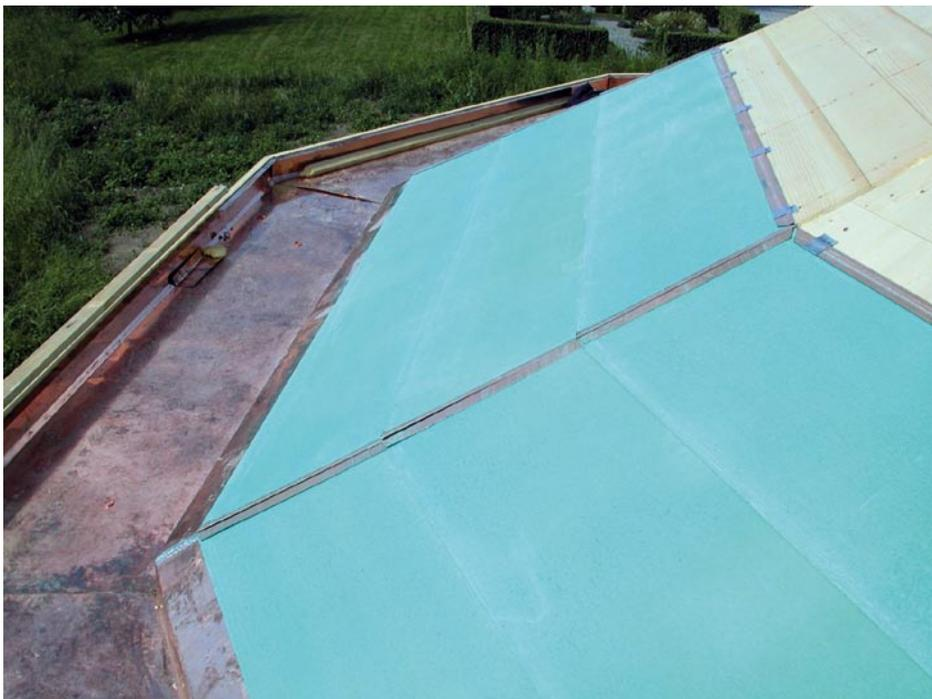
Die Rinne aus blankem Kupferblech ist dachseits überhöht. Aus optischen Gründen wurde die Bekleidung in einen tiefer liegenden, aufgesetzten Einhängestreifen eingehängt.
