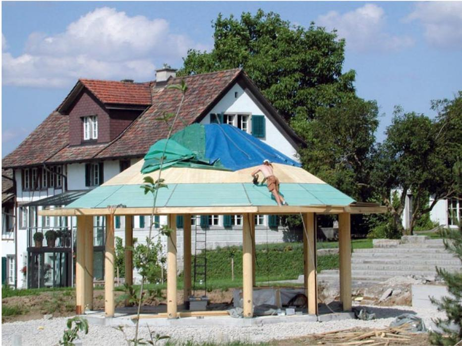
Die Dachentwässerung ist in vier der zwölf Holzstützen integriert: PE-Abflussleitungen DN 75 mm sind mit Steckmuffen an geschweißte Kupferrohre angeschlossen.
