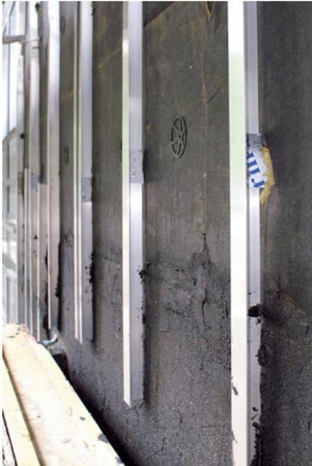
Schritt für Schritt: Die L-förmigen Aluminiumprofile spielen eine tragende Rolle.
