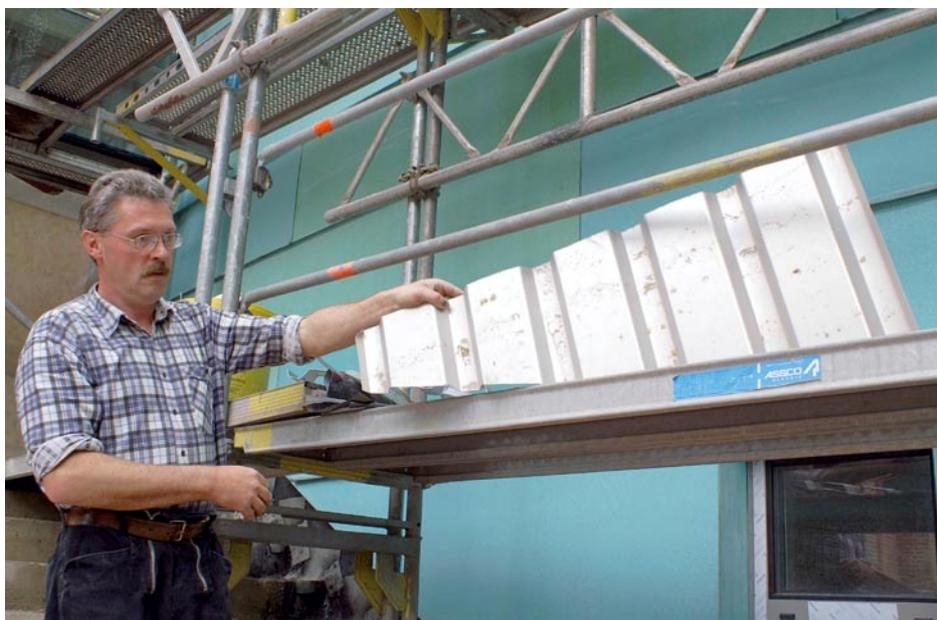
Guter Grund: Hans Bornemann bereitet die Unterkonstruktion aus Trapezprofilen vor.
