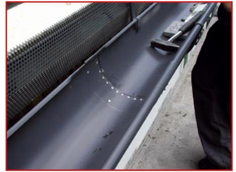
Wie man eine Rinnennaht an lackiertem Aluminium herstellt, war für die meisten Lehrlinge neu: rund 5 cm überlappen, eine Zwischenlage aus selbst gemachtem Ölpapier, Vollnieten im Abstand von ca. 15 mm und dann die Naht durchsetzen. So wird sie auf Dauer dicht und auch ausreichend stabil. Auf dem Foto ist das Lochblech gut zu erkennen, denn selbstverständlich wurde das Dach als belüftete Konstruktion ausgeführt.
