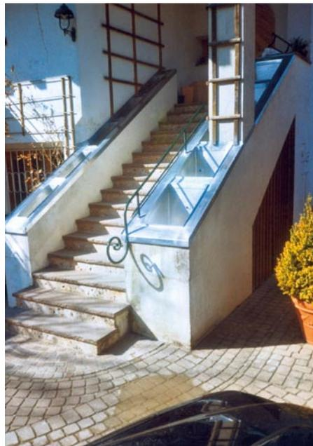
Zur einfacheren Montage wurde das Geländer erst abgeschnitten, erhielt etwas größere Einfassungsstützen aufgelötet und wurde anschließend wieder angeschweißt.
