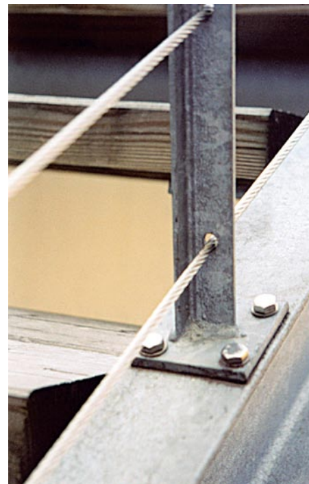
Wenig Chance für Kontakt-Korrosion: Edelstahlschrauben in Verbindung mit verzinktem Stahl sind zumeist unproblematisch.
