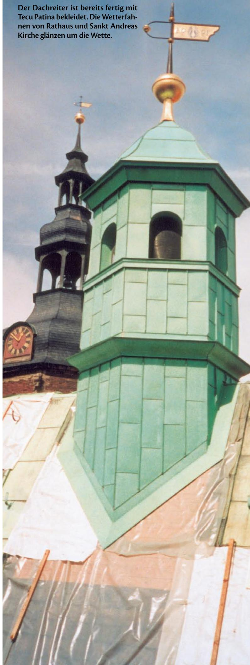
ren. Die gesamte Konstruktion musste einer grundlegenden Sanierung unterzogen werden. Statische Untersuchungen und Anforderungen des Brandschutzes zeigten, dass neben dem Austausch der schadhaften Hölzer eine weitreichende zimmermannsmäßige Überarbeitung des Dachstuhls notwendig war. Und für die rissige, alte Kupferdeckung gab es praktisch keine Rettung mehr.
