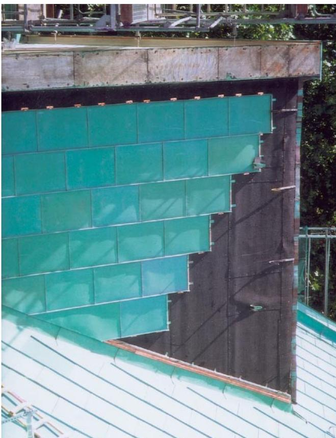
Ebenso wie das Hauptdach wurde das Zwerchhaus mit 600 mm breiten, vorprofilierten Scharen in Doppelstehfalztechnik gedeckt.
