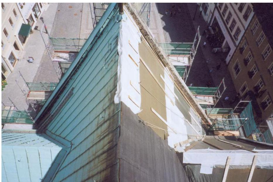
Fehlerhafte Falzausbildungen hatten zu starren Verbindungen geführt, sodass sich das Material nicht frei ausdehnen konnte und Risse an den fixierten Stellen zwangsläufig die Folge waren. Die alte Kupferdachdeckung musste komplett abgetragen werden.
