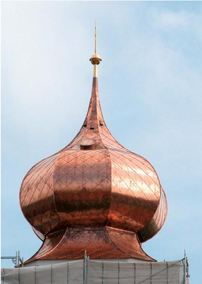
Der Zwiebelturm ist fertig, Kreuz und Kugel sind auch schon montiert.
