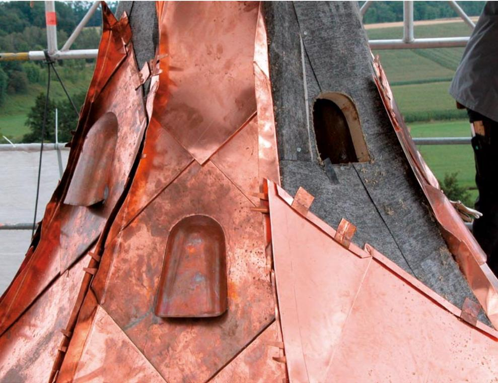
◀ Die selbstgefertigten Lüfter werden eingebaut.
