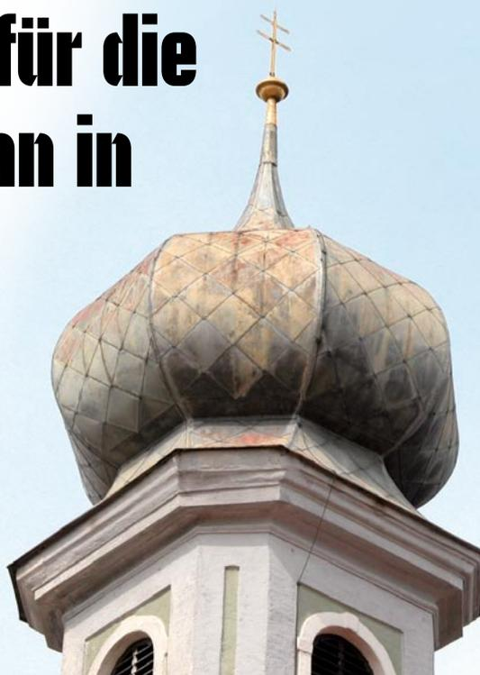
Der Zwiebelturm von St. Stefan in Unterschwillach trägt noch seine alte Deckung aus verzinktem Stahlblech.
