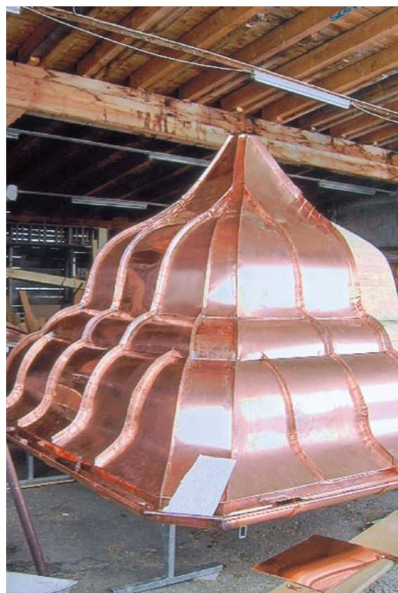
• 8 • Schürze und obere Bahnen sind eingepasst und verfalzt. Der noch offene Bereich kann erst auf der Baustelle fertiggestellt werden.
