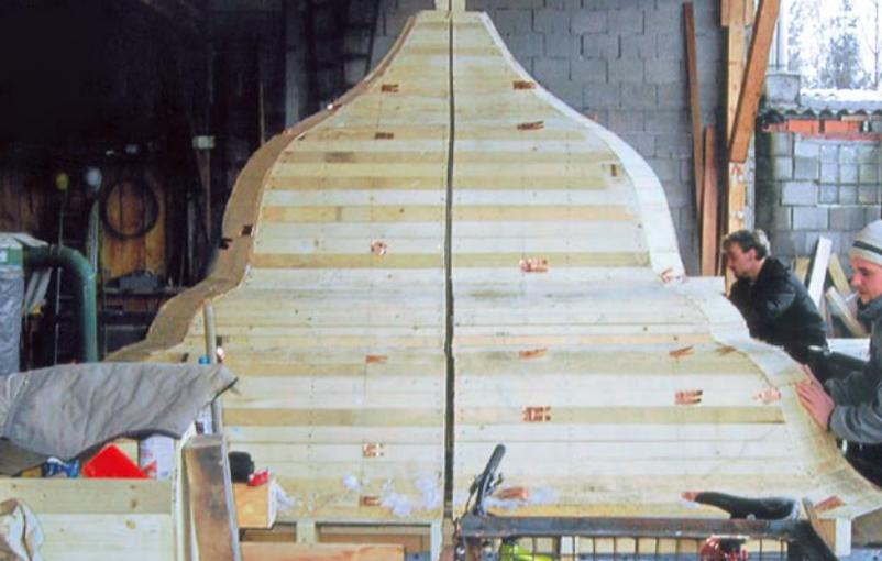
• 5 • ... wenn die beiden Hälften knirsch zusammen sitzen, mit allen nur verfügbaren Kräften eingelotet und ordentlich im Wasser, können die vorgefertigten Kupferschalen endlich präzise an die Turmhaube angepasst werden.
