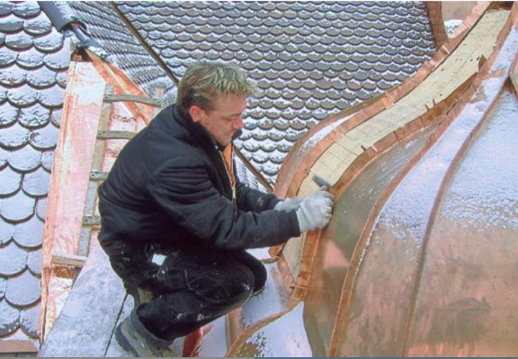
▲ • 10 • Ein Spengler hoch über den Dächern Schwabings: Ein Autokran hat den Eckturm bereits auf den bestehenden Sockel gesetzt. Nun werden noch die letzten Kupferscharen montiert sowie Kehl- und Gratanschlüsse gefertigt.
