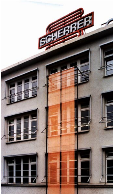
Im Selbstversuch: Die Bemusterung der Kupferbahnen in originaler Größe und Ausführung war zwar aufwendig, aber eine wichtige Entscheidungshilfe.
