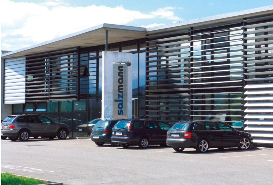
Das Firmengebäude der Salzmann Formblechtechnik GmbH in Altach, Vorarlberg.
