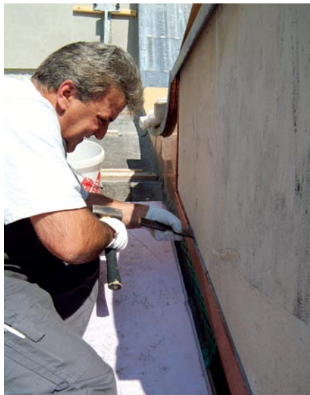
Ausstemmen der Fugen zwischen Kupferbekleidung und Sandsteinfassade mit Bleiwolle.
