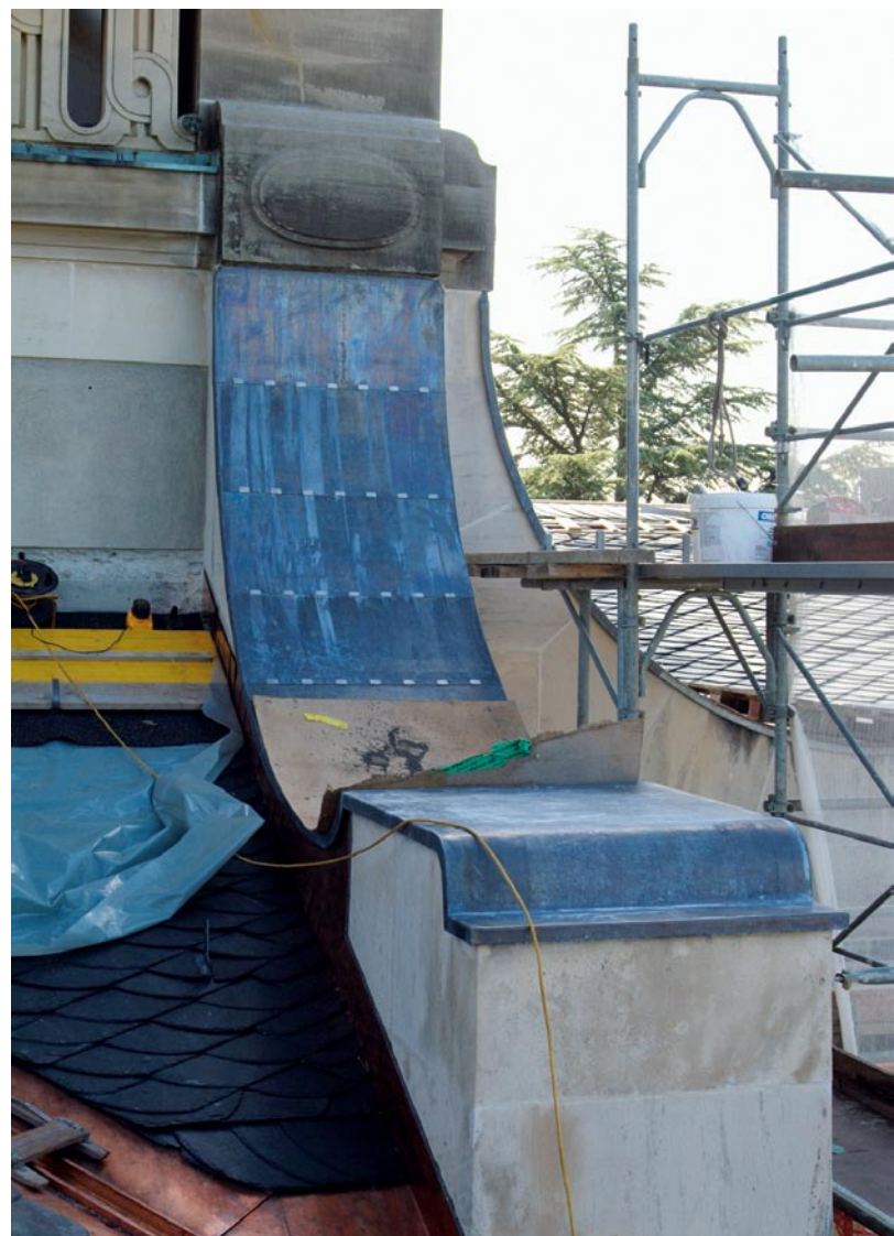
Abdeckung der Fassadengiebel mit Walzblei, das an den Radien geschweißt wurde.
