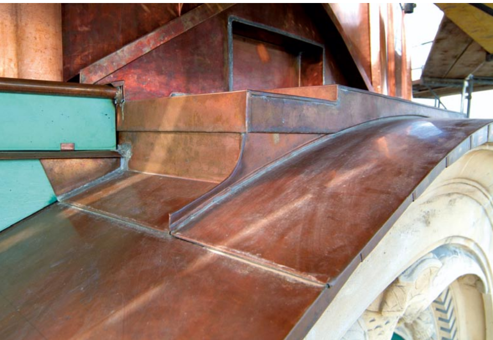
Jeder der vier Uhrenerker ist mit einem Kupferdach vollständig abgedichtet. Auf die Kupfersockel in der Bildmitte werden später die restaurierten Vasen aus Sandstein gesetzt.
