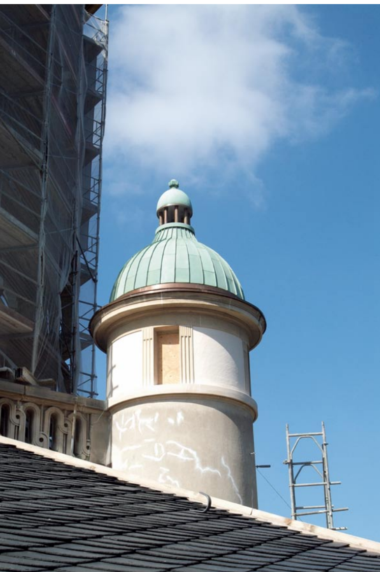
Der Kaminturm hat schon seine Kuppel aus restaurierten, originalen Kupferscharen erhalten.
