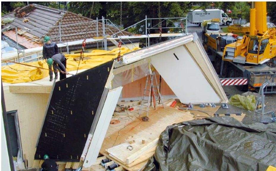
Der erste Bügel wird vorsichtig mit dem Kran auf der Bodenplatte abgesetzt und an den vorbereiteten Stellen befestigt.
