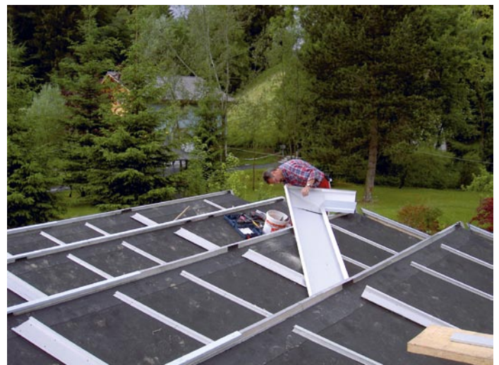
Spenglermeister Renato Egli montiert die vorgefertigten Aluminium-Blenden auf dem Dach.
