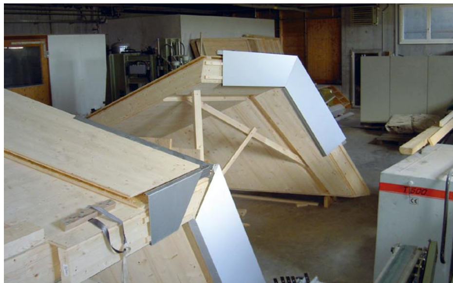
Die Form der Aluminium-Blenden wurde vorab exakt an Musterkonstruktionen in Originalabmessungen ermittelt.
