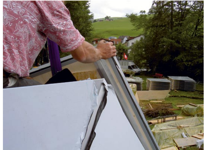
Ein vorgefertigtes Element zur Fassadenbekleidung wird millimetergenau an der hölzernen Bügelkonstruktion eingehängt.
