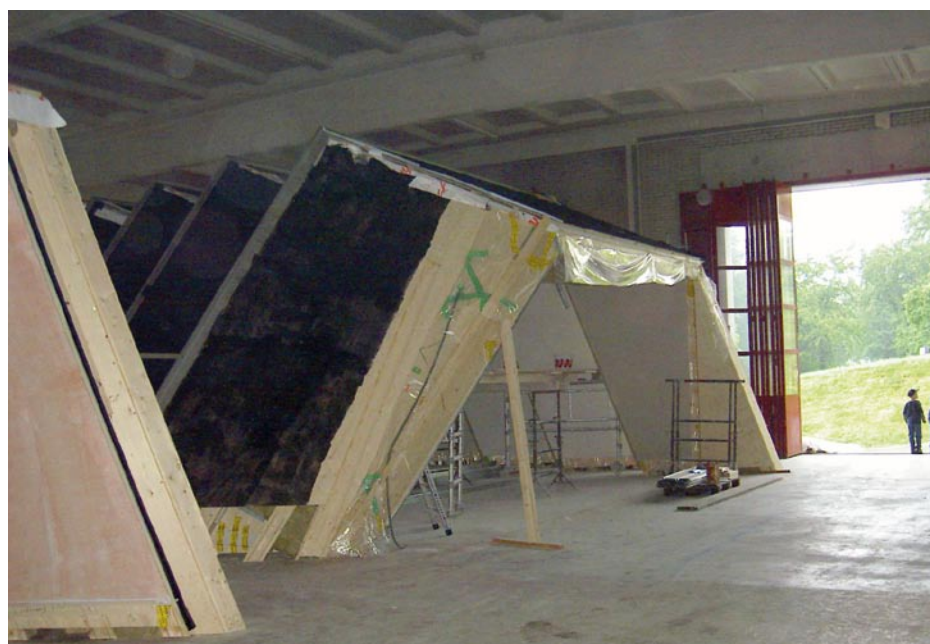
Auch die hölzernen Bügelkonstruktionen wurden mit allen Schichten, Kastenrinnen und Randprofilen vorab in der Werkstatt angefertigt.
