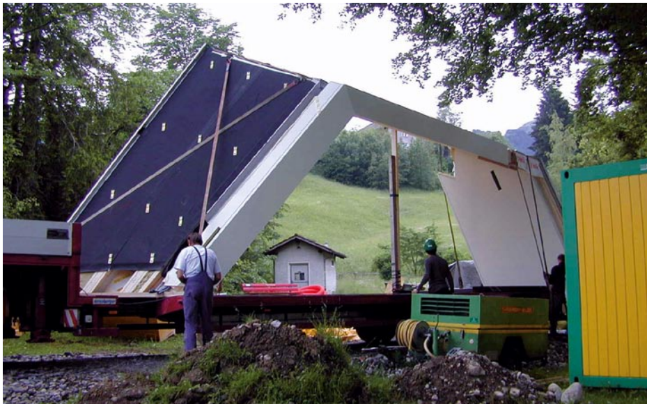
Fest auf einem Spezialfahrzeug verzehrt, wurden nacheinander alle elf Bügel von der Werkstatthalle zur Baustelle transportiert.
