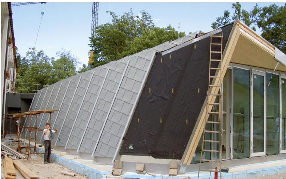
Schließlich sitzt der elfte Bügel an Ort und Stelle – allerdings noch ohne Fassadenbekleidung.
