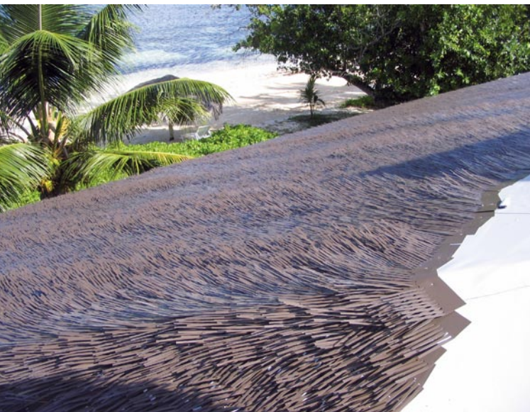
Hier ist die „wilde“ Verlegetechnik für die unterschiedlich aufgebo- genen Aluschindeln deutlich zu sehen.
