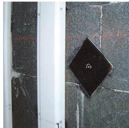
An den „Hutprofilen“ aus Aluminium wur- den die Krallenplatten befestigt.
