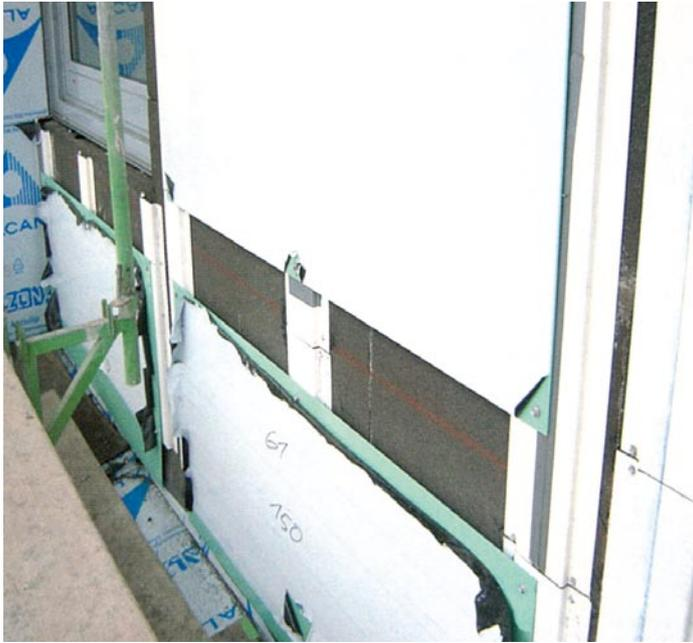
Während der Montage der Aluminiumtafeln wird die Schutzfolie nur an den Ecken gerade soweit vorsichtig abgezogen, dass die Schrauben eingedreht werden können.
