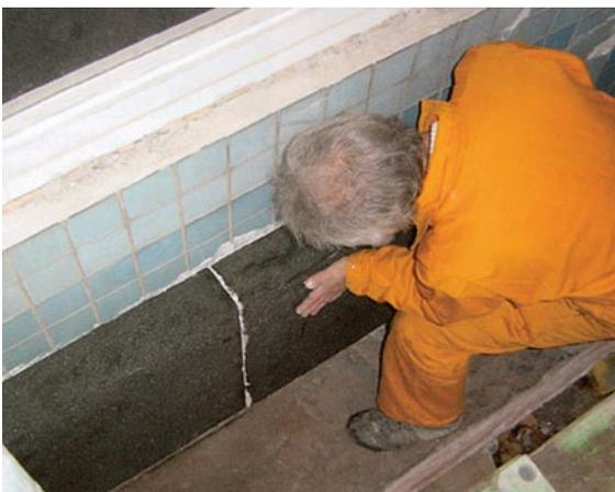
Mit Einkomponenten-Dispersionkleber zwischen Wand und Dämmplatten sowie in den Quer- und Lagerfugen entsteht ein luft- und wasserdichter Aufbau.
