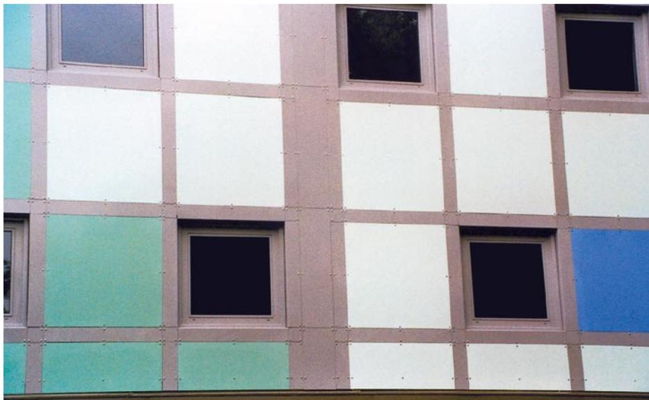
geringeren Abständen gesetzt werden als im unteren Bereich. Auf die Hutprofile schraubte die Kentzler-Mannschaft 3 mm starke, stückbeschichtete Falzonal-Tafeln und verklebte sie zusätzlich. Als Abstand von der Dämmschicht zur Metallbekleidung ließ man nur einen 15 mm dünnen Luftspalt, um eventuell anfallendes Kondensat an der Dämmoberfläche abzuleiten.
