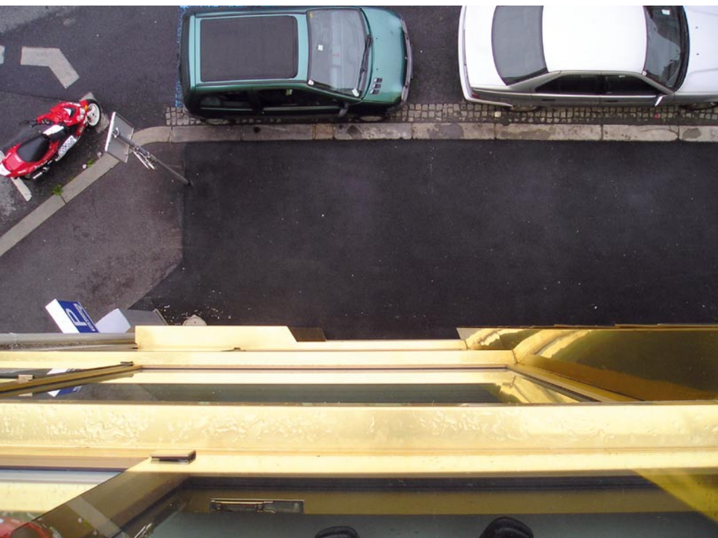
Details – glänzend gelöst: Fensterbänke, Laibungen und Sturzbekleidungen wurden aus Tecu-Gold-Tafeln hergestellt und perfekt in Spengler-technik ausgeführt.
