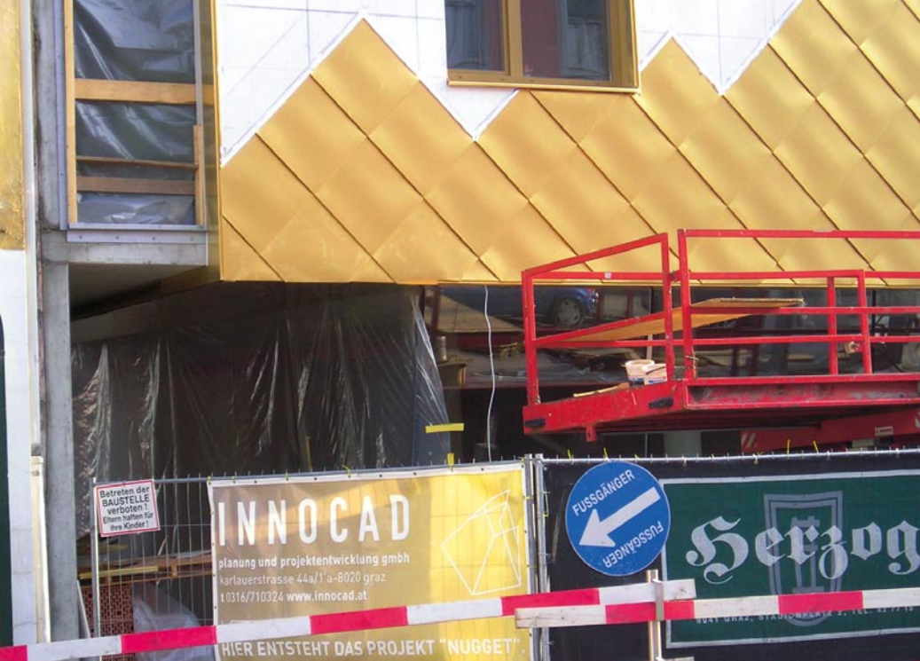
System-Schindeln aus Tecu-Gold werden mit Kupferhafte auf dem Unterbau aus Schalung und Brandschutzplatten befestigt.
