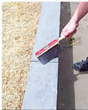
Untergrund reinigen
