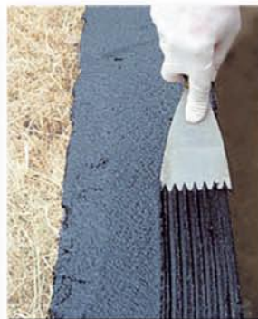
Enkolit® mit Rillenspachtel auftragen
