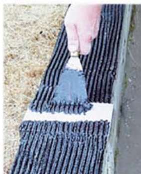
Enkolit® auf Stoßblech auftragen
