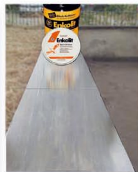
Fertig verklebte Abdeckung
