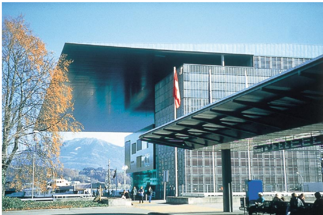
Das Kongress- und Kulturzentrum Luzern mit der bis zu 45 m frei auskragenden Dachfläche.
