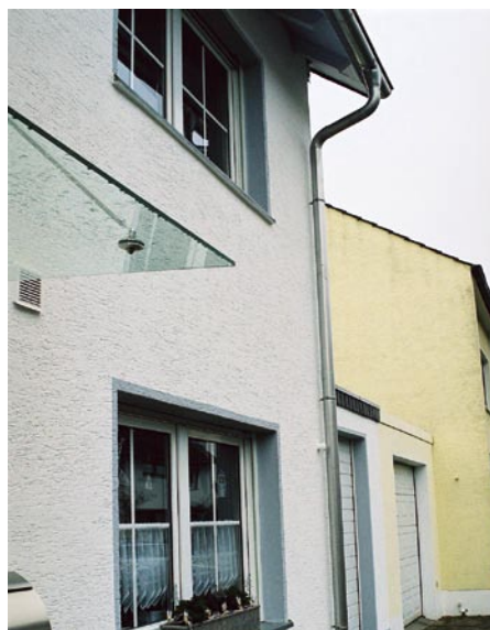
... an den Traufseiten des Satteldachs wollte der Hausbesitzer in Edelstahl haben.
