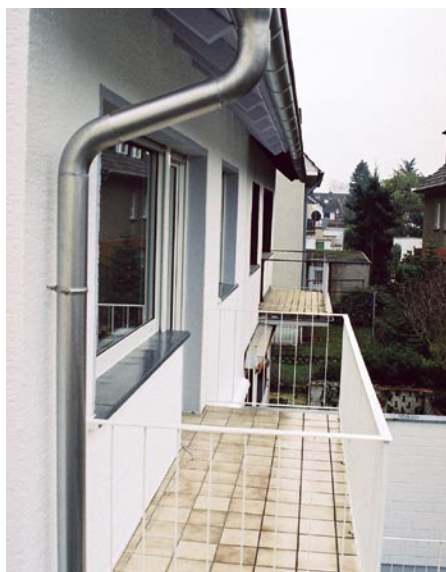
Auch die Dachentwässerung mit sämtlichem Zubehör ...
