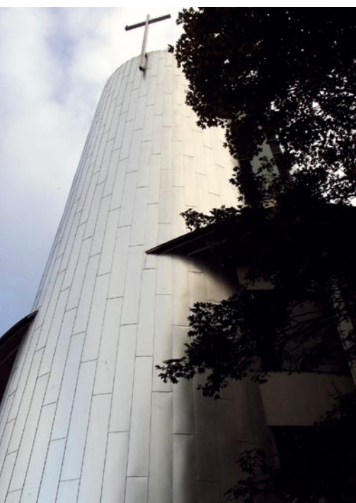
Bild 8.: Die Fortsetzung der Falzstruktur über dem, die Turmfassade teilweise umfassenden, Kirchendach wurde durch Ausgleichschindeln erreicht.
