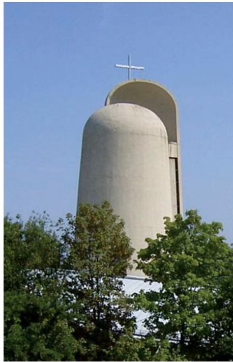
Bild 4.: Der direkte Vergleich macht es deutlich: Die Grundform des Turmes wurde durch die Sanierung nicht verändert.
