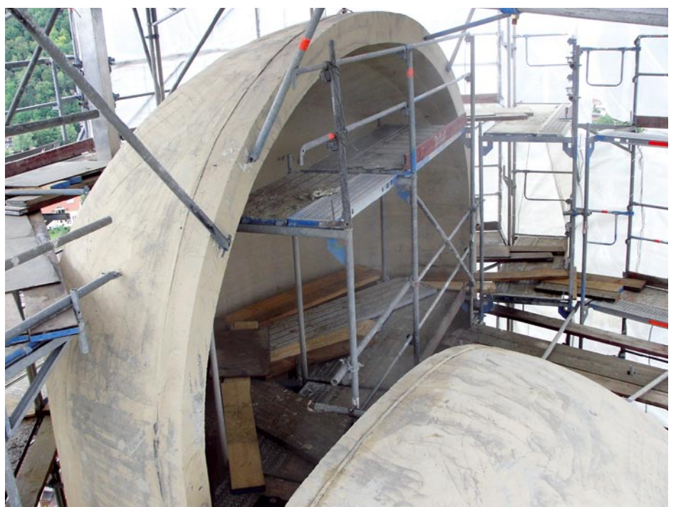
Bild 6.: Der quarzsandgestrahlte Untergrund vor dem Aufkleben der Trennlage.
