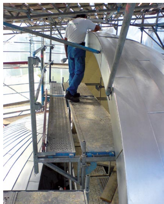
Bild 8.: Die Fortsetzung der Falzstruktur über dem, die Turmfassade teilweise umfassenden, Kirchendach wurde durch Ausgleichschindeln erreicht.
