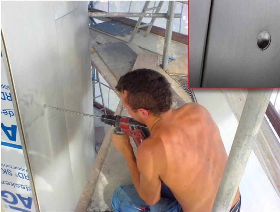
Bild 10.: Dominik Offenhäuser beim Setzen eines Gerüstankers. Beim Gerüstabbau wurde das Bohrloch mit einer Kappe aus Tecu-Zinn geschlossen.
