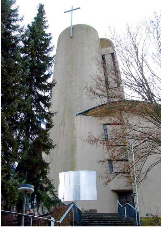
Bild 3.: Ein etwa 10 m 2 großes Fassadenmuster zeigt unterschiedliche Falz- und Verbindungstechniken und erleichtert die Detailabstimmung.
