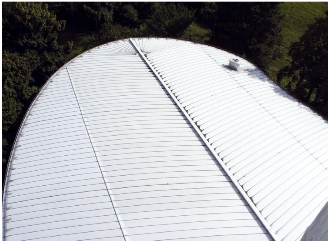
Bild 2.: Das gut erhaltene Kirchendach aus Farbaluminium in Stehfalztechnik wirkt, von der Turmkuppel aus betrachtet, wie ein echtes „Kirchenschiff“.
