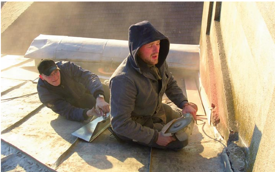
Das Anbringen der Profile war eine besonders staubige Arbeit, denn der Putz war bereits überall mürbe und brüchig.
