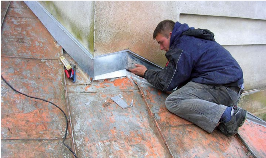
Für die Turmanschlüsse mussten spezielle Profile konstruiert werden, die in dieser Form in keinem Lehrbuch stehen.
