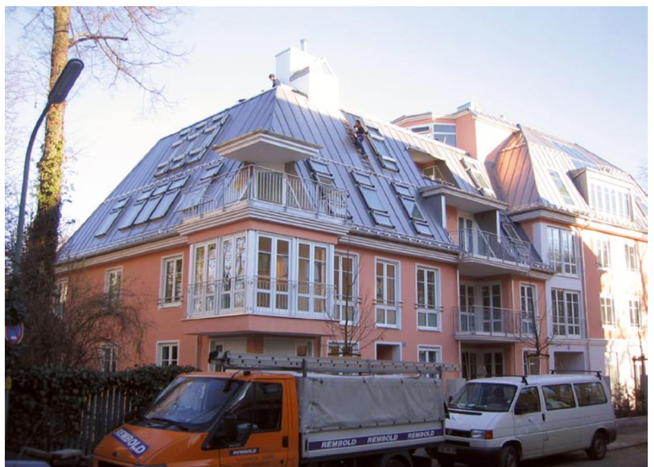
Nach der Fertigstellung der Arbeiten steht für die Spengler der Firma Rembold das Firmenfahrzeug zur Abfahrt bereit.
