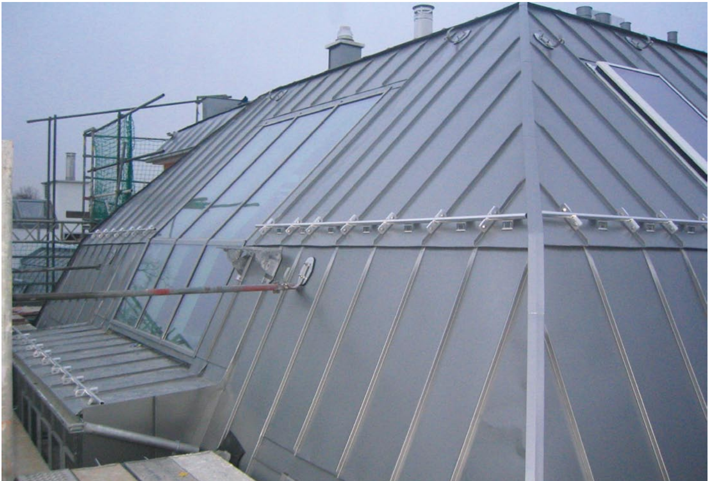
Großflächige Pfosten-Riegel-Verglasungen wurden in der Metalldeckung flächenbündig eingearbeitet.
