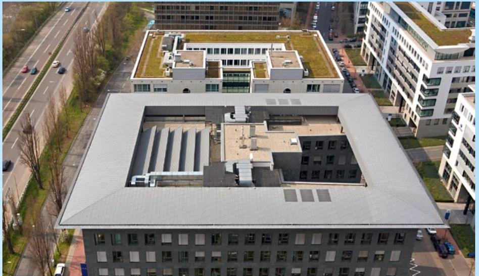
Im Vergleich mit umliegenden Standardbedachungen ist das Titanzinkdach der ING-DiBa-Zentrale ein echter Blickfang, zumal die homogene Dachfläche durch keinerlei Dachaufbauten gestört wird. Großvormatige Rauten umfassen auch die Dachuntersicht und bilden dabei ein homogenes Ganzes.
